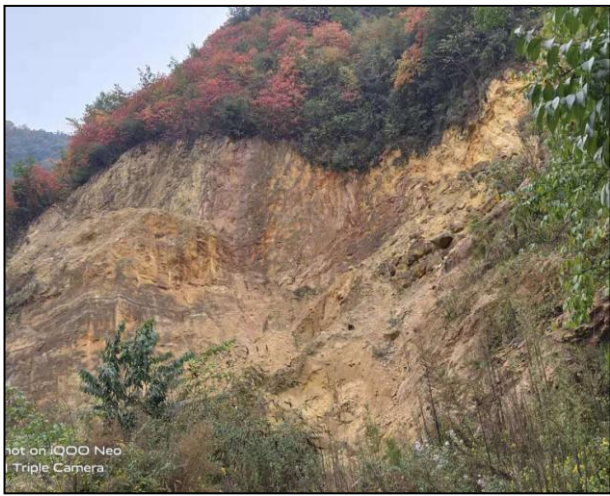
照片 1-11 CK3 露采面（镜向 125°）
