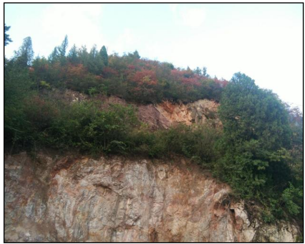
照片 1-12 CK4 露采面（镜向 105°）
