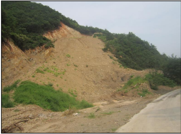
照片 1-9 CK1 露采面（镜向 50°）
