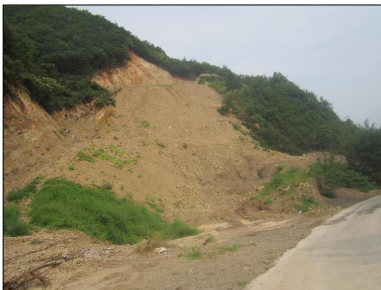
照片 3-5 CK1 露采面（镜向 50°）
