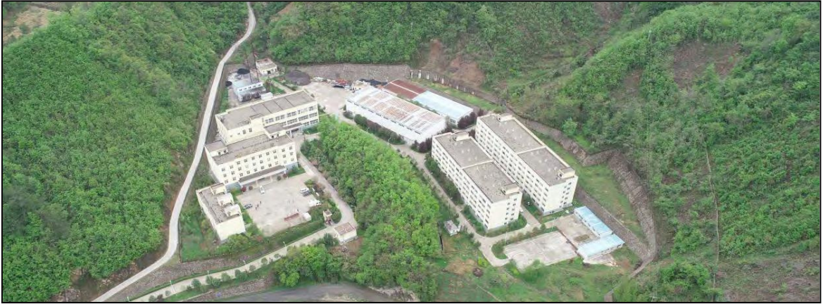
照片2-18 生活区滑坡治理效果
