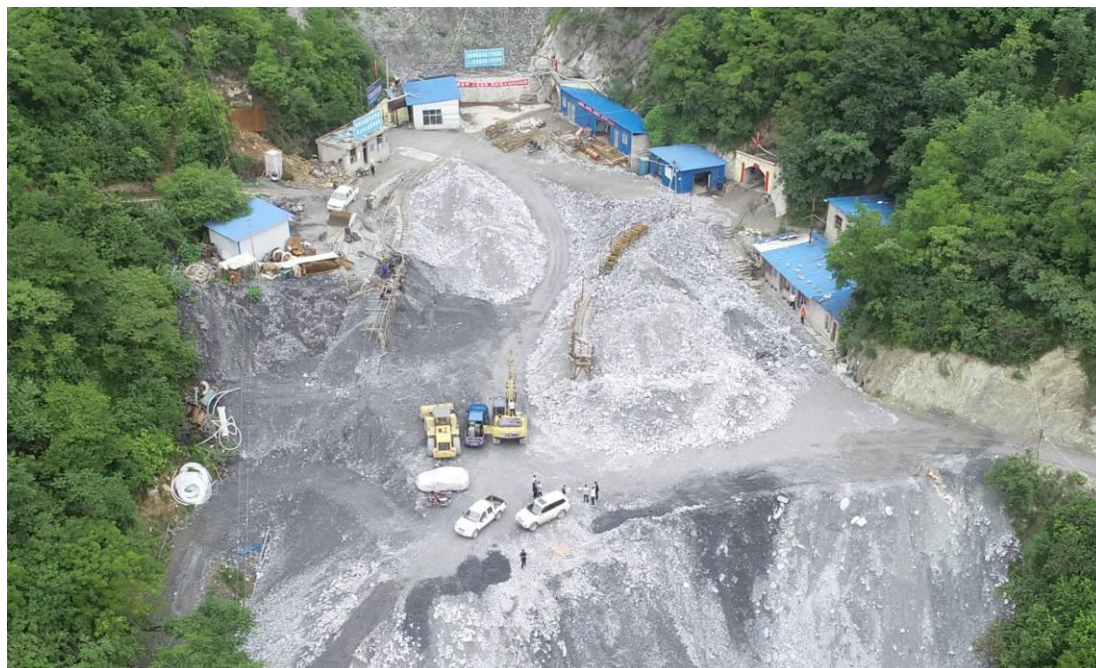
照片 1-15 采场工业广场(镜像 280° )
