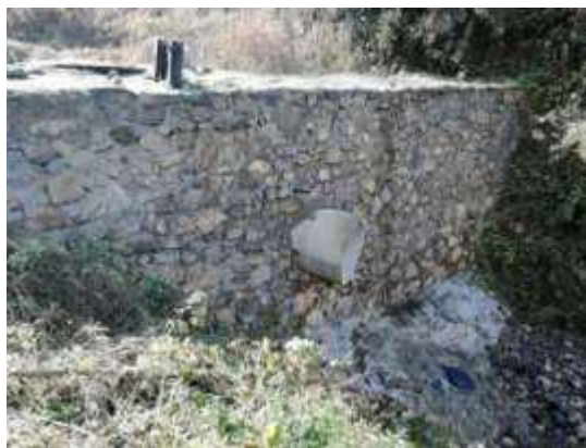
照片 2-19 拦渣坝及排水涵管
