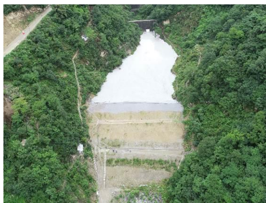
照片 3-17 尾矿堆存破坏地形地貌
