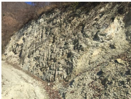
照片 3-14 道路切坡破坏地形地貌
