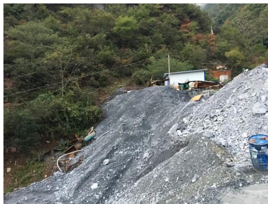
照片 3-15 废石堆存破坏地形地貌
