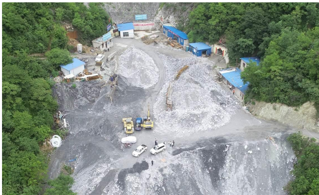
照片 1-4 采场工业广场(镜像 280° )
