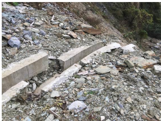
照片 2-13 截排水沟
