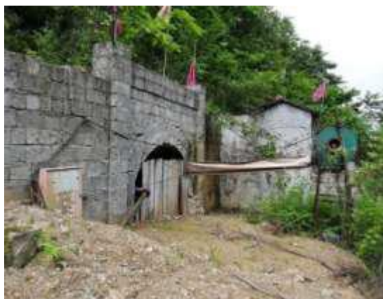
照片 2-17 硐口加固工程
