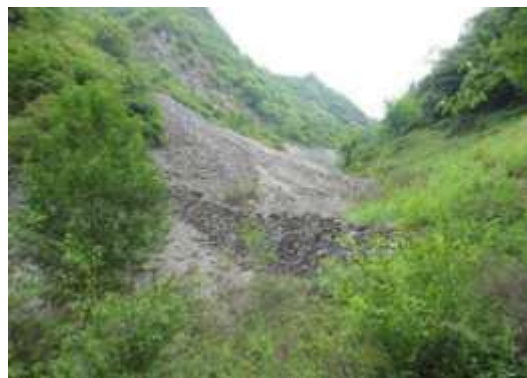
照片 2-18 拦渣挡墙
