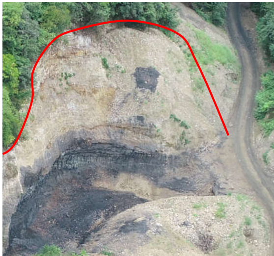
照片 3-2 BY1 崩塌隐患 (345°)
