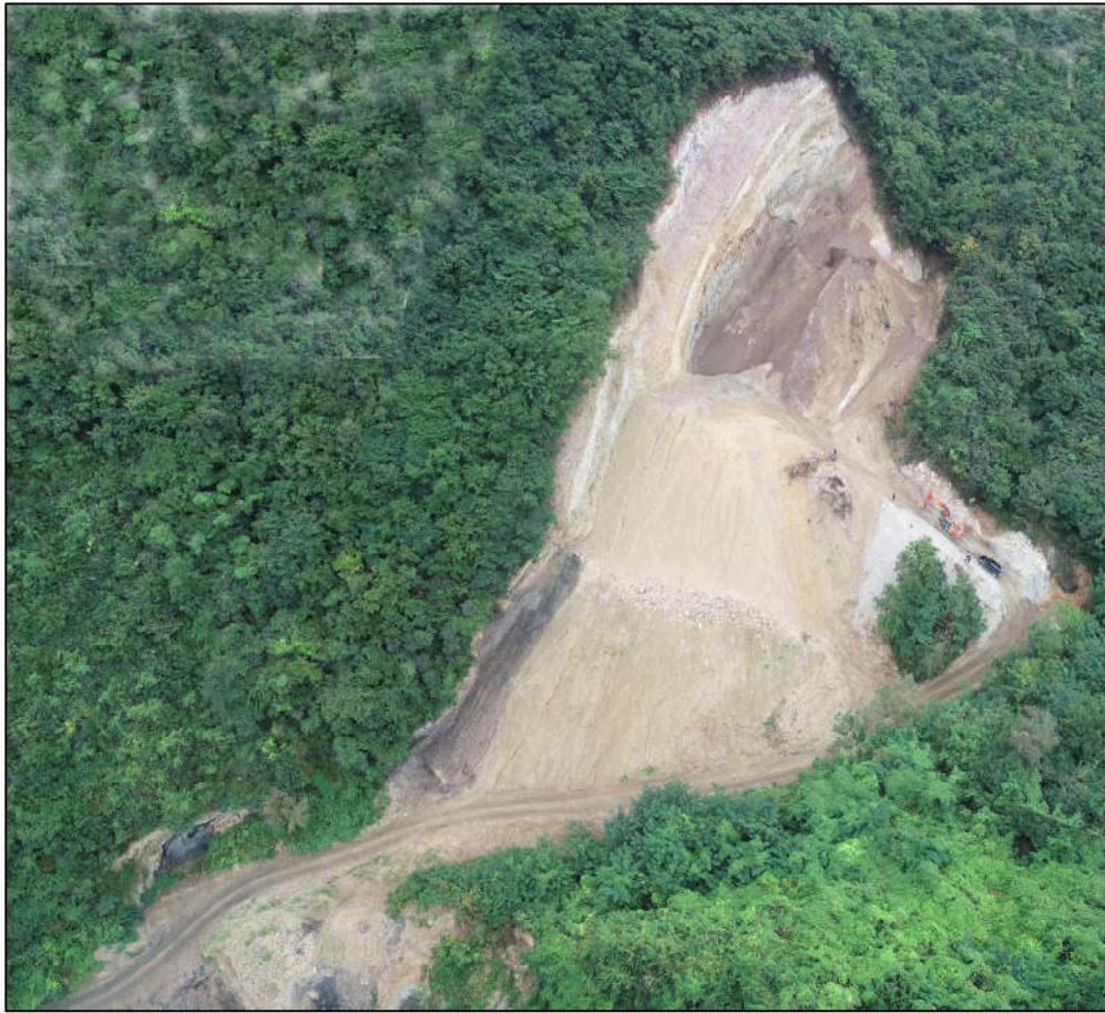
照片 3-2 NY1 泥石流隐患沟谷现状 (200°)
