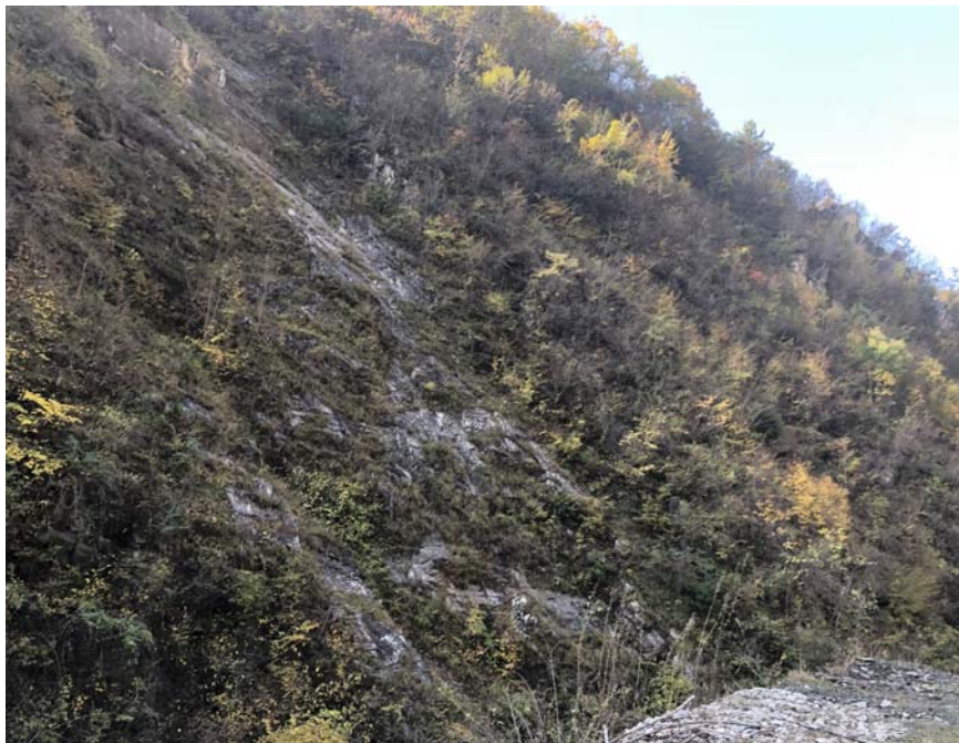
照片 3-4 拟建矿山道路局部（镜向 234°）
