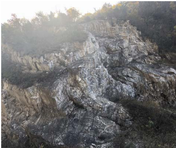
照片 3-1 B1 崩塌隐患（镜向 195°）
