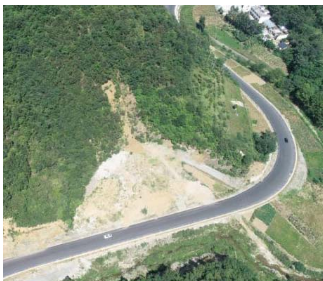
照片 3-5 堆料场现状 (镜向 16°)
