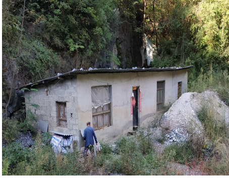
照片 3-6 值班室（压占）
