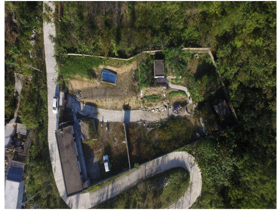
照片2-11 炸药库边坡挡墙(镜向95°)
