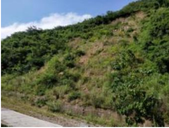
照片 2-14 裸露边坡复垦（镜像 185°）
