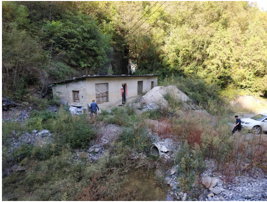
照片2-10 ZD1排水涵洞(镜向25°)
