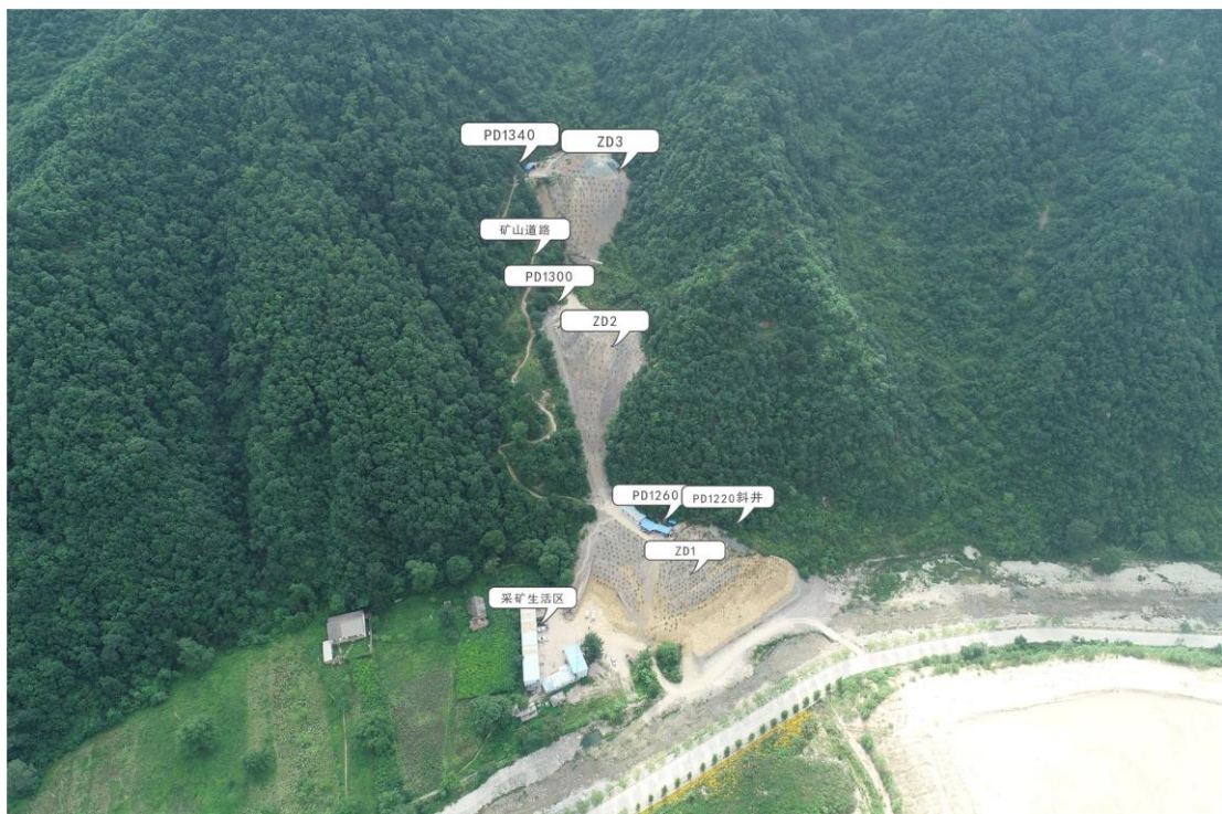
图 3-12 采矿生活区和堆渣损毁土地现状图
