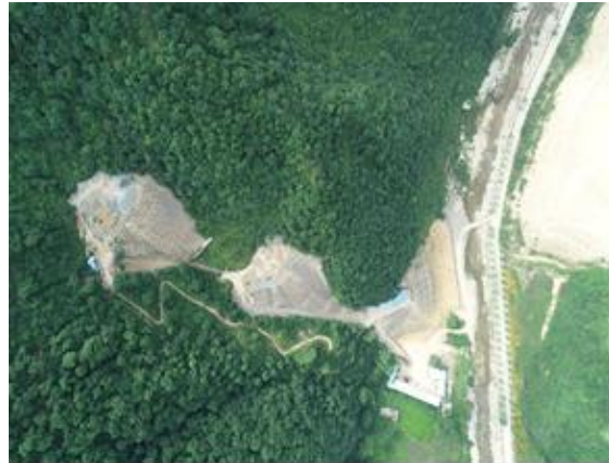
图 3-10 下扁沟泥石流沟
