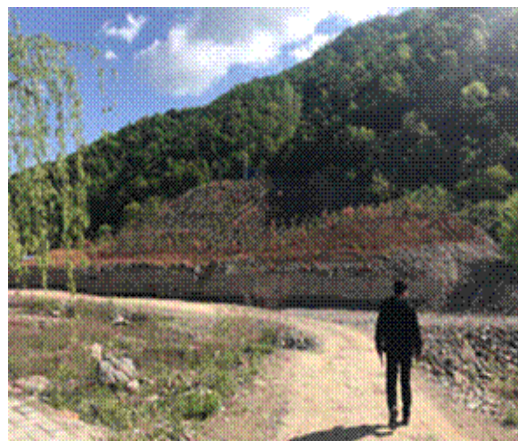
图 2-23 ZD2 治理现状
