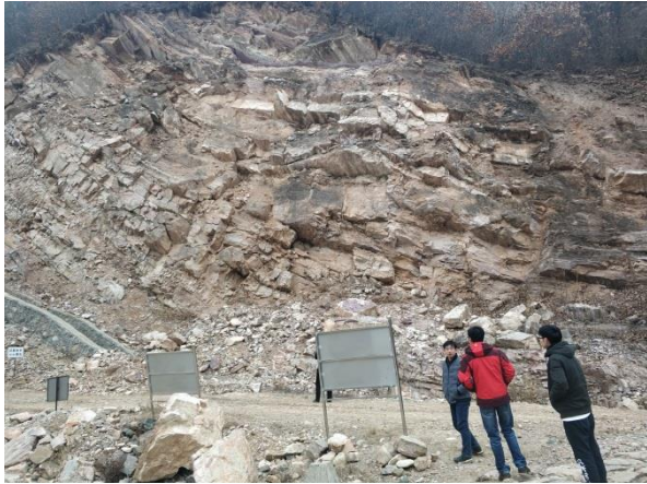
图 3-3 崩塌 B1 现状图
