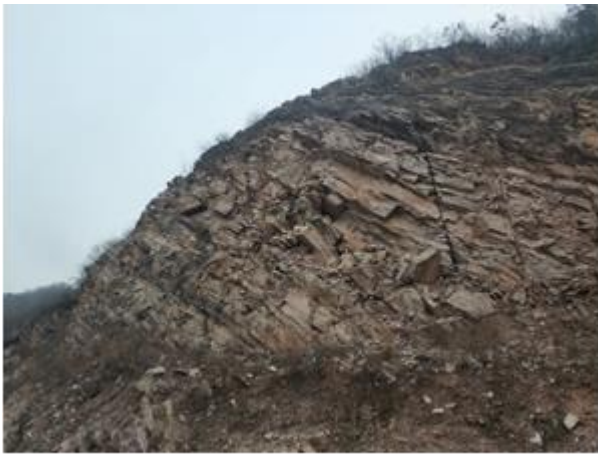
图 3-5 崩塌 B2 现状图
