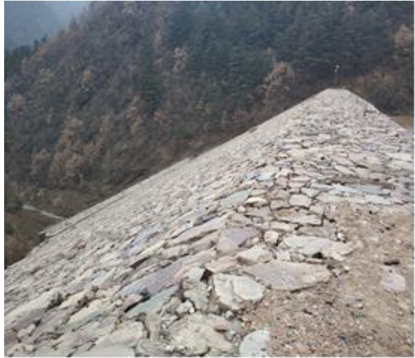
图 1-9 尾矿库滤水坝
