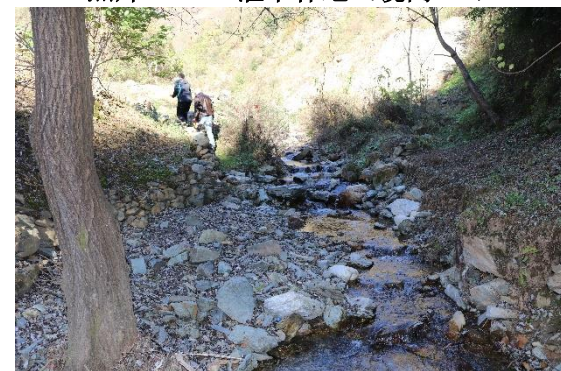
照片 2.4-4 沟渠 (镜向 NW)
