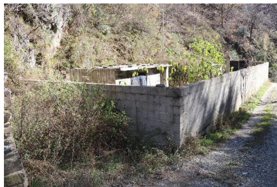
照片 1.4-6 炸药库（镜向 SE）
