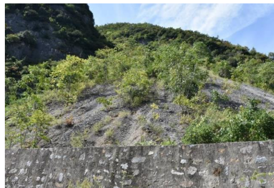
照片 2.6-2 废石堆底部拦渣墙（镜向 SW）
