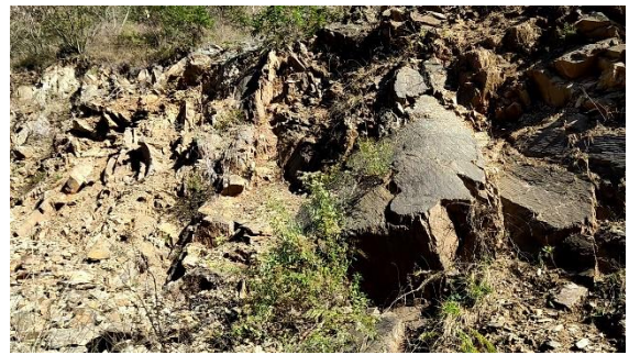
照片 3.2-2 崩塌局部（镜向 E）
