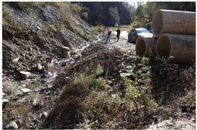
1.3-4 拟建工业场地位置近景（镜向 NE）
