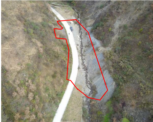
照片 1.3-3 拟建工业场地位置（镜向 NE）
