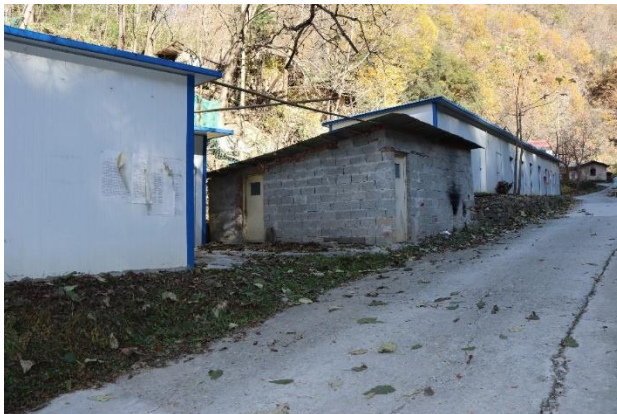
照片 1.3-1 原办公生活区（镜向 NE）
