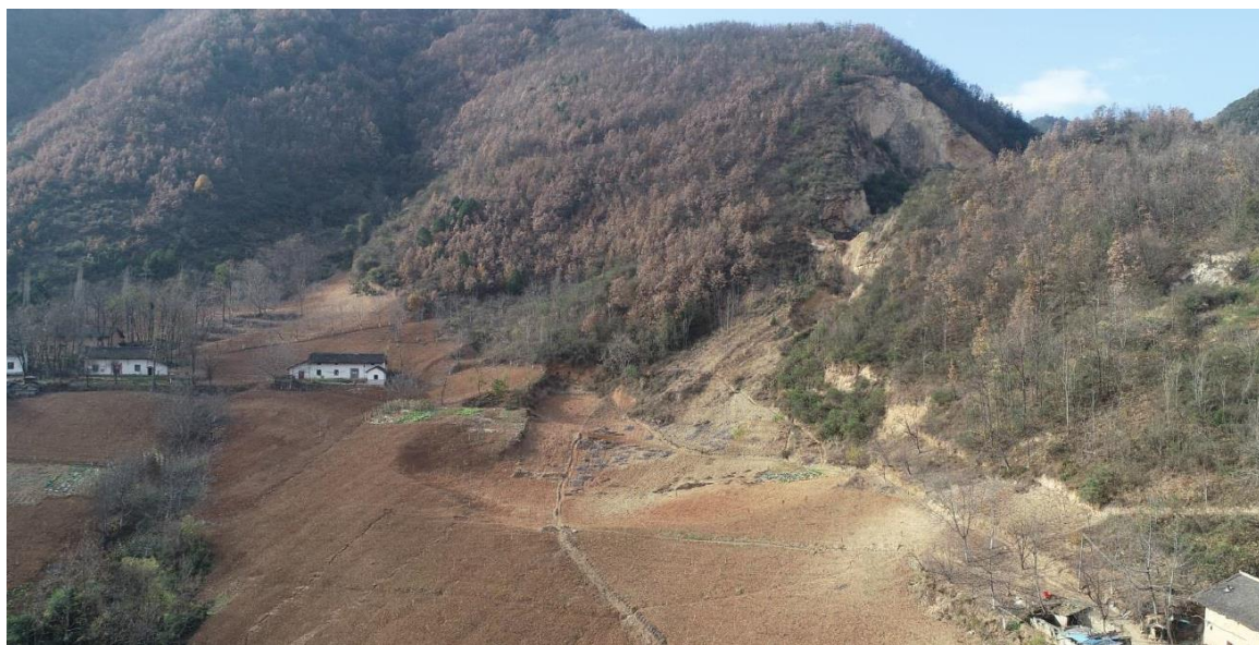
照片 2.6-3 采空塌陷填堵治理后（镜向 NW）
