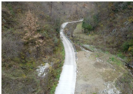
照片 2.5-1 通村公路（镜向 NE）
