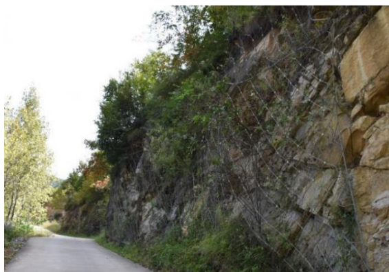
照片 2.6-1 道路边坡危岩体治理（镜向 SE）
