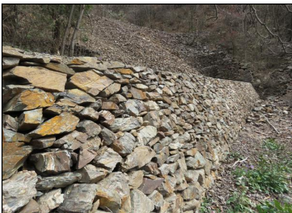
照片2-16 干砌石挡墙2（镜向40°）
