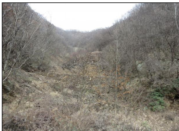
照片2-17 干砌石挡墙3（镜向240°）
