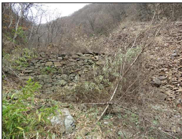
照片 2-14 Z2 废渣堆拦渣坝（镜向 290°）
