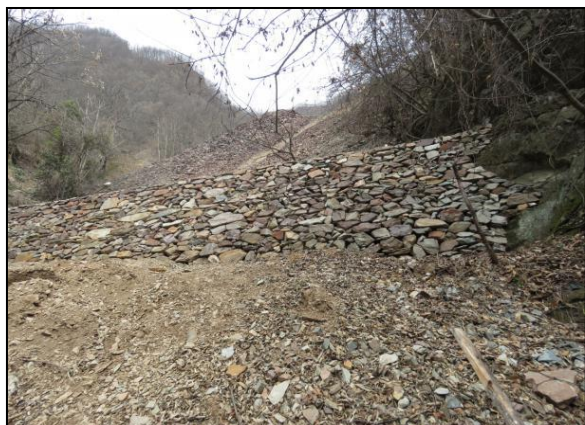
照片2-15 干砌石挡墙1（镜向290°）
