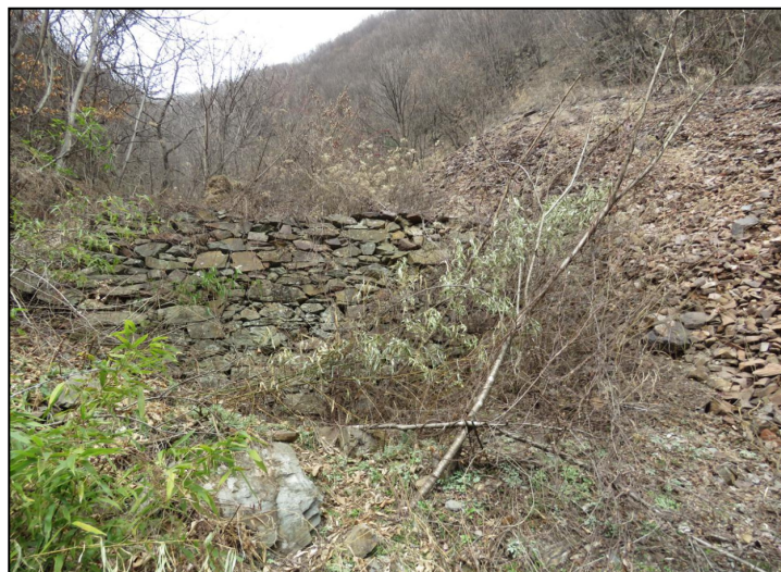
照片3-3 Z2废渣堆拦渣坝（镜向320°）
