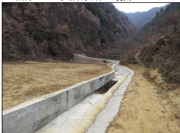
照片2-19 截排水沟1（镜向240°）
