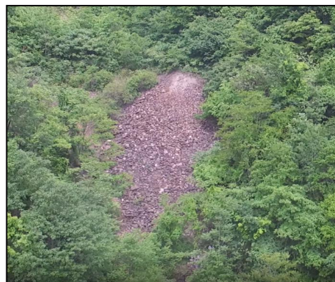
照片 3-9 Z4 废渣堆（镜向 345°）
