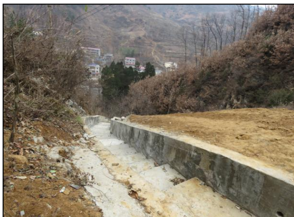
照片2-20 截排水沟2（镜向35°）
