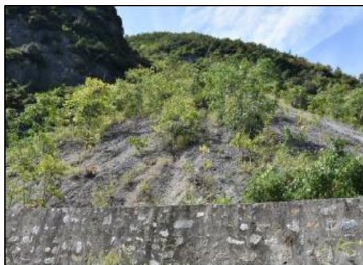
照片2-16 废石堆修建挡墙镜像 265°
