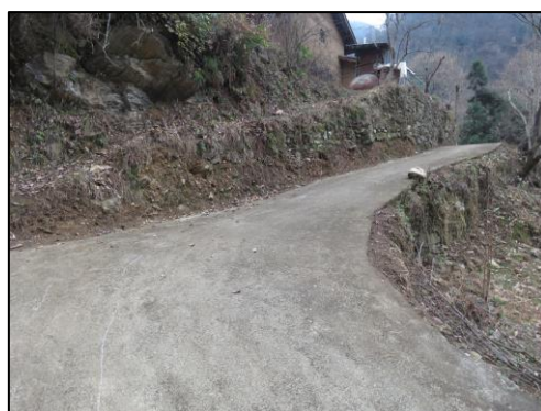
照片2-12 切坡修路 镜像80°
