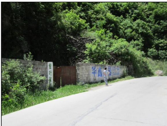
照片2-9 地质灾害隐患治理后照片
