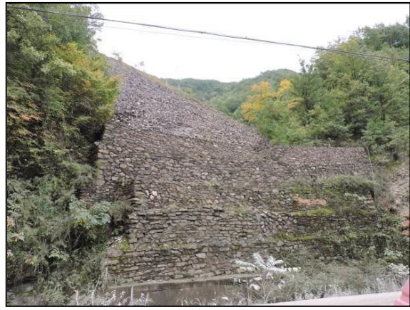
照片2-12 渣堆底部挡墙工程
