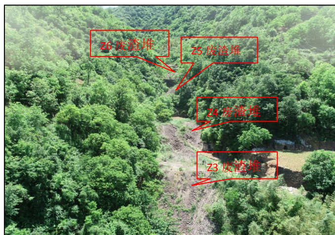
照片 1-9 竹园沟内废渣堆（镜向 182°）
