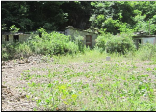
照片 3-9 冷水沟内工棚 (镜向 96°)
