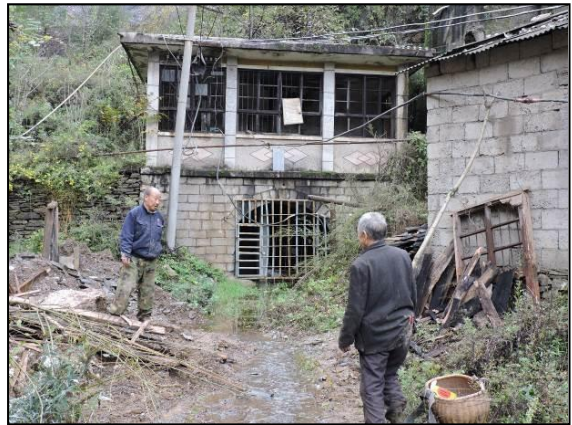
照片 2-13 硐口封堵工程
