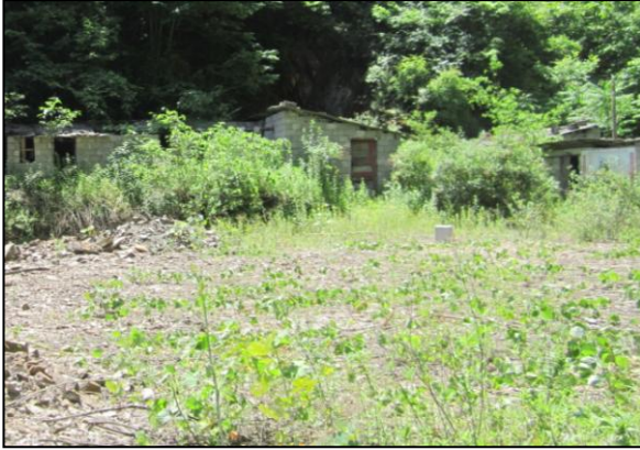
照片 1-1 冷水沟内工棚(镜向 96° )
