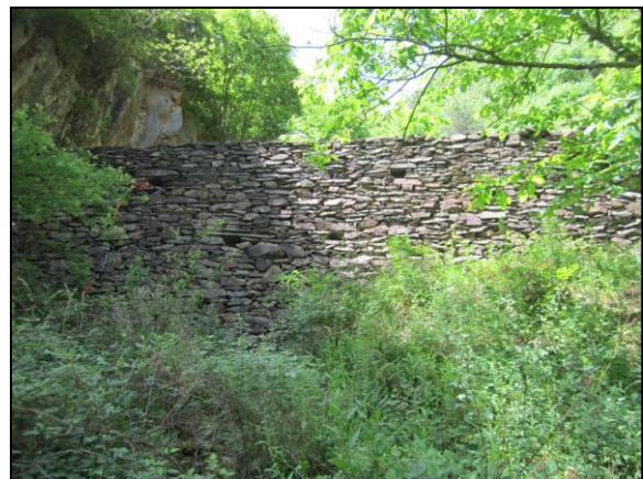
照片2-10 Z1废渣堆下部干砌石挡墙
