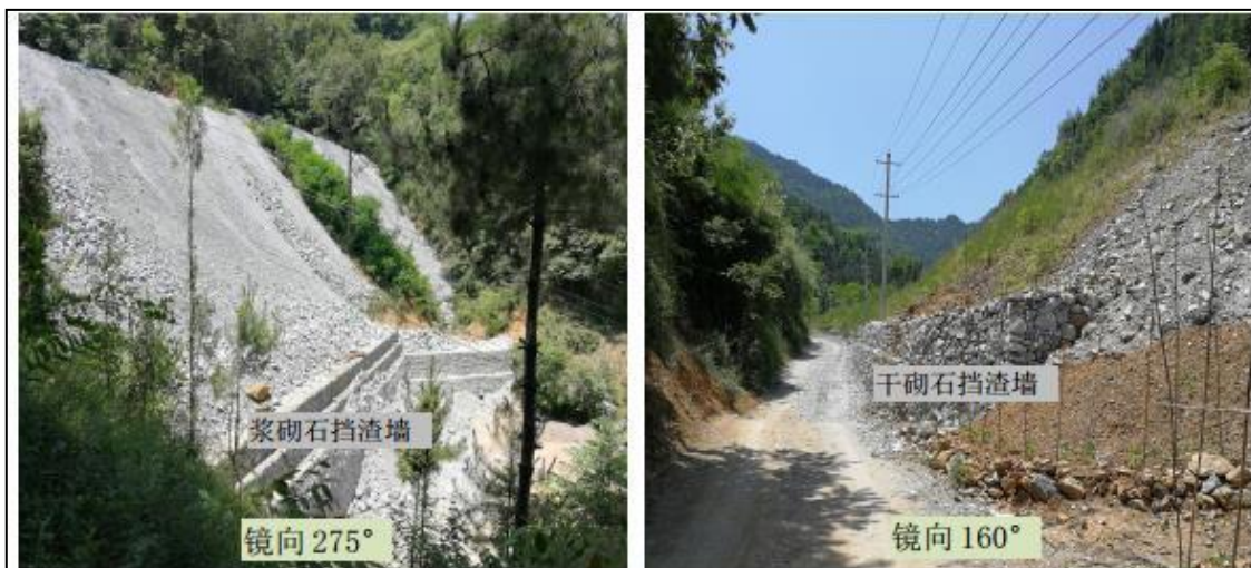
照片 2-13、照片 2-14 秤锤沟沟口废渣场修建的挡渣墙
