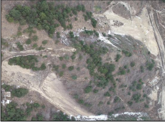
照片 3-4 桥沟 Z1、Z2 废渣堆（镜向 0°）
