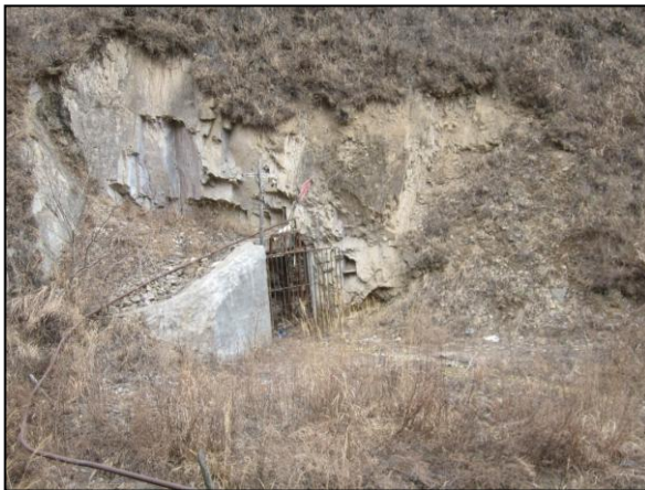
照片 3-1 BY1 崩塌隐患（镜向 85°）
