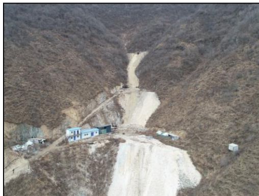
照片 1-2 凤凰山矿段 KT1 工业场地
