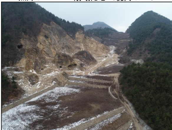
照片 3-2 BY2 崩塌隐患（镜向 245°） (2) 泥石流隐患
