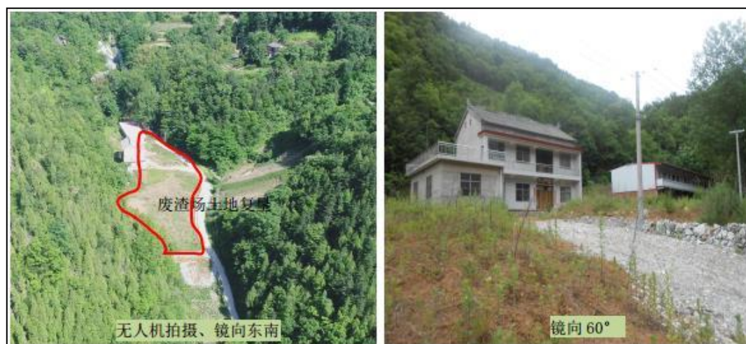
照片 2-15、照片 2-16 阳坡沟 Z13 废渣场土地复垦情况
