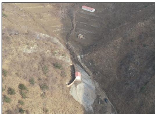
照片 1-3 凤凰山矿段 KT3 工业场地
