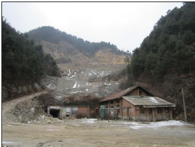
照片 1-5 道岔沟-铁炉子村工业场地
