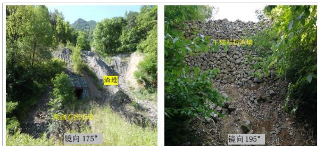
照片 2-11、照片 2-12 小眼沟 Z01 和 Z02 废渣场底部修建的挡渣墙
