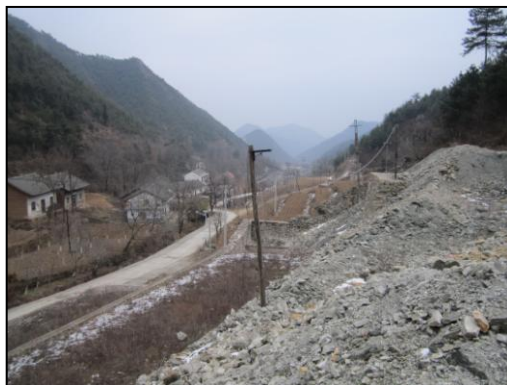
照片 3-18 道岔沟 Z16 废渣堆(镜向 110°)
