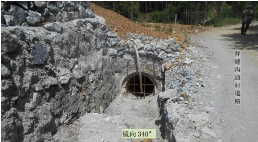
照片 2-17 秤锤沟废渣场北东侧修建的挡渣墙及排水沟
