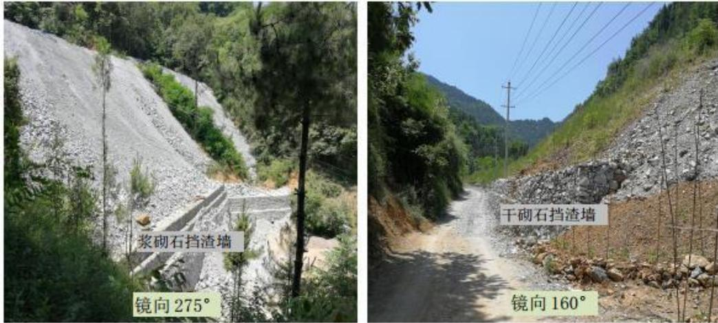
照片 2-15、照片 2-16 秤锤沟沟口废渣场修建的挡渣墙
