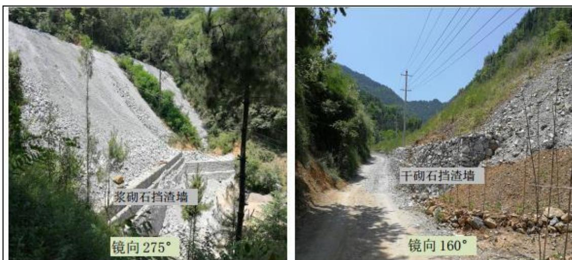
照片 2-12、照片 2-13 秤锤沟沟口废渣场修建的挡渣墙
