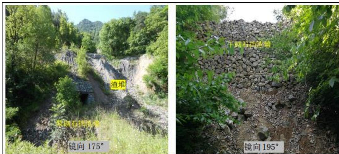
照片 2-10、照片 2-11 小眼沟 Z01 和 Z02 废渣场底部修建的挡渣墙
