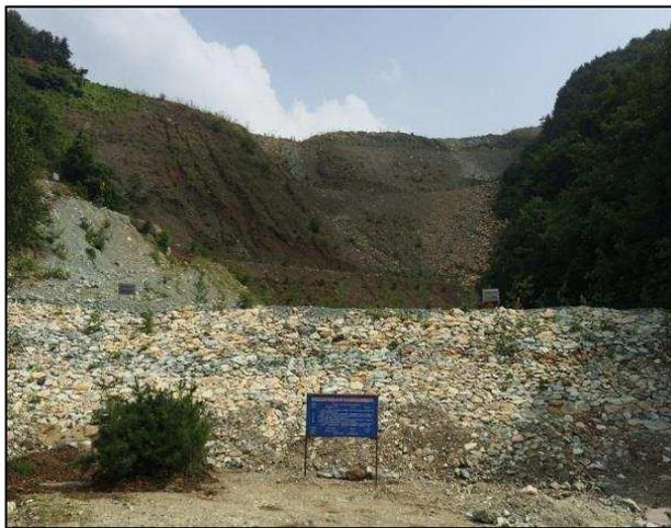
照片 2.6-1 铁树沟废石场浆砌石挡墙
