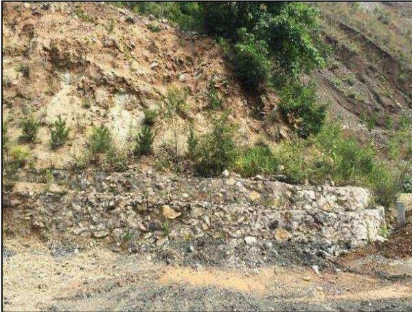
照片2.6-3 滑坡前缘浆砌石挡墙
