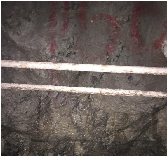
照 2-10 坑道正常地段
