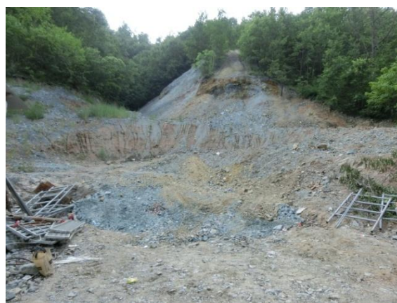
照 2-17 PD3 坑口废石清运完成
