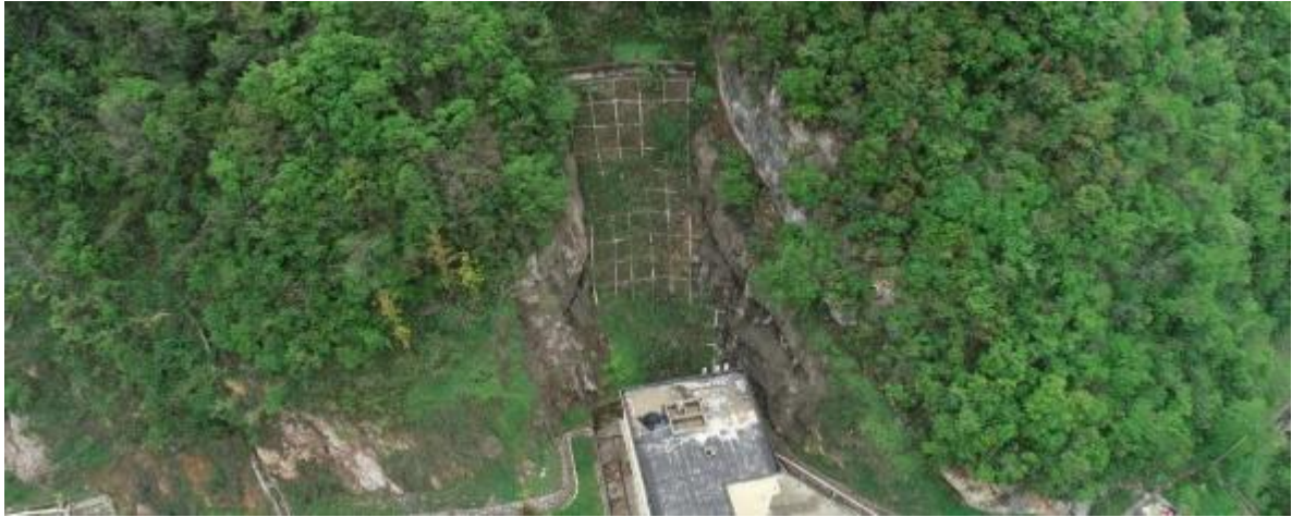
照 2-21 千家坪化验室西侧滑坡治理效果
