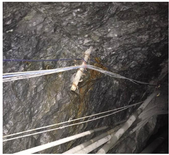
照 2-11 坑道内断裂地段渗水现象
