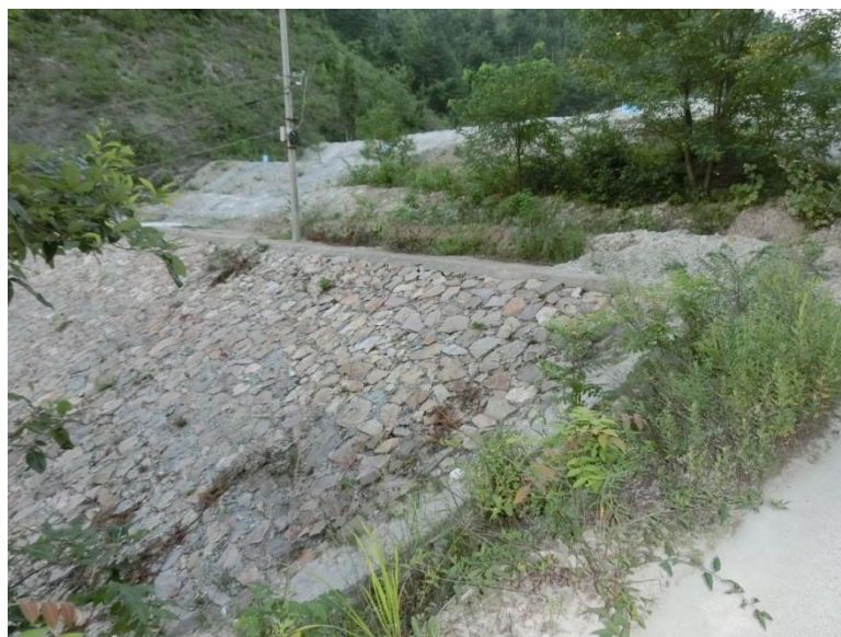
照 2-18 尾矿库绿化工程
