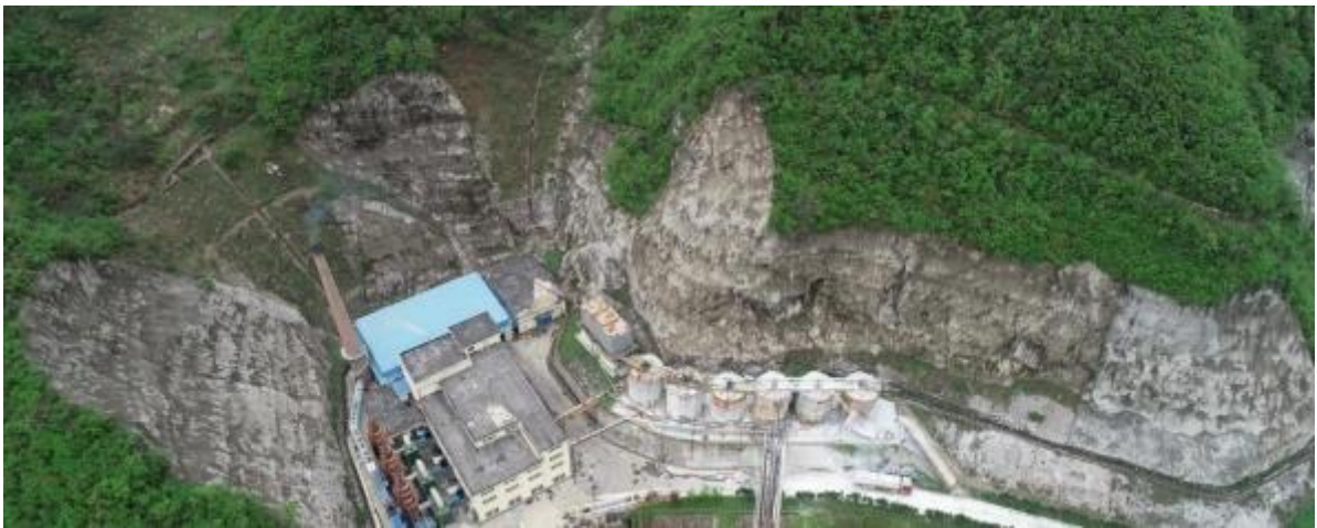
照 2-20 千家坪锅炉房滑坡隐患治理效果
