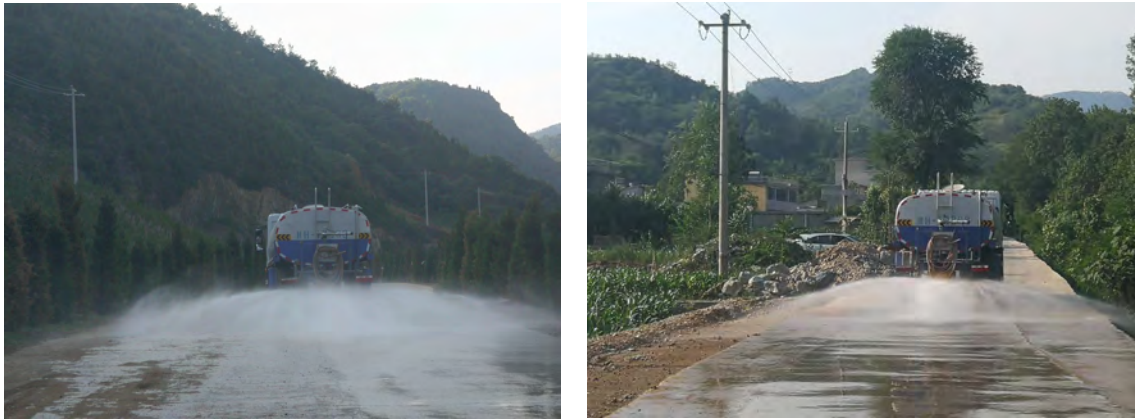
照片 2-10 运输道路防尘洒水作业
