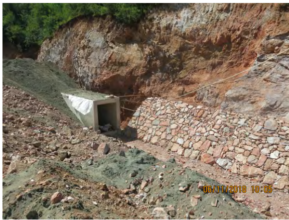
照片 2-13_战马沟尾矿库新修排泄系统（镜像 160°） 照片 2-14_老虎沟尾矿库新修排泄系统（镜像 80°）
