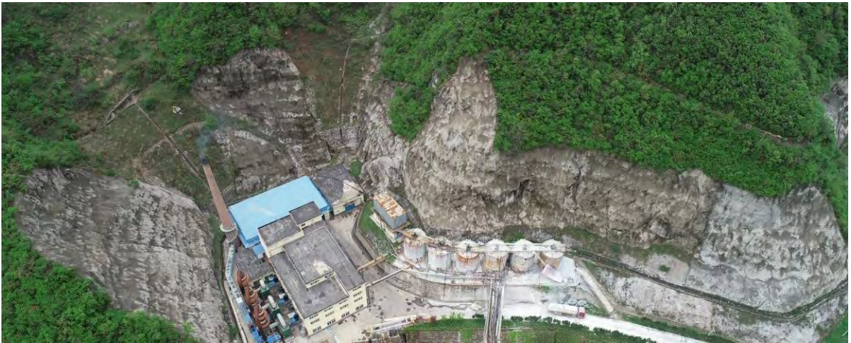
照片2-18_锅炉房滑坡治理效果（镜像150°）
