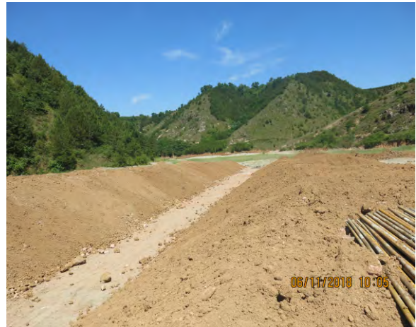
照片 2-11_战马沟尾矿库坡面种树（镜像 30°） 照片 2-12_战马沟尾矿库沉积滩覆土（镜像 280°）
