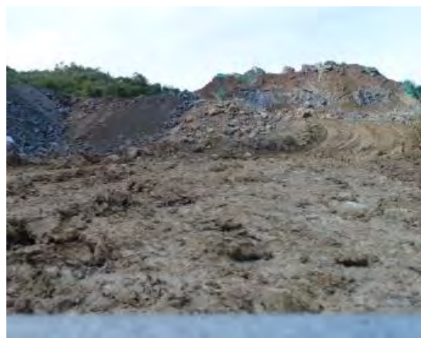
照片 2-7 治理后 B3 崩塌隐患
