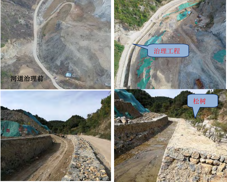
2-8 青岩沟河道治理工照片
