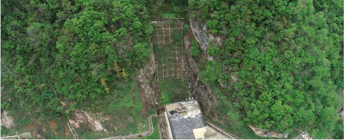
照片2-19_试化楼滑坡治理效果（镜像160°）
