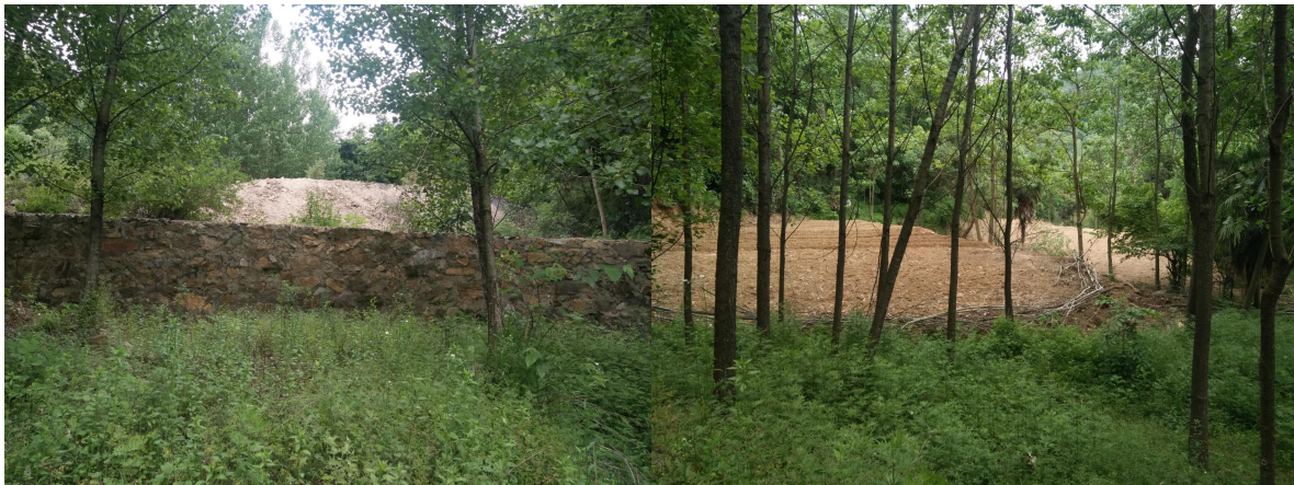
照片 2-14 PD3 平硐口 ZD3 废渣堆已建拦渣墙
