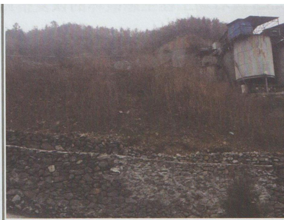
照片 2-11 办公生活区 1 左侧边坡植被恢复
