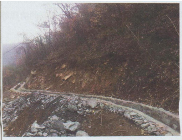
照片 2-17 废渣堆沿山体修建截水沟
