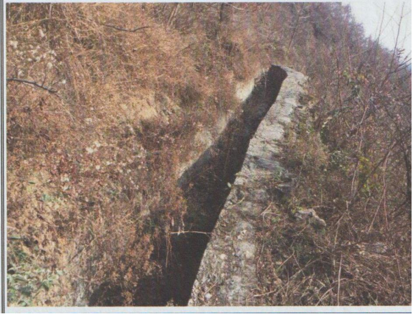
照片 2-13 库内截水沟
