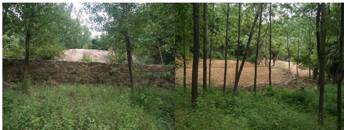
照片 3-5 ZD3 废渣堆及拦渣墙
