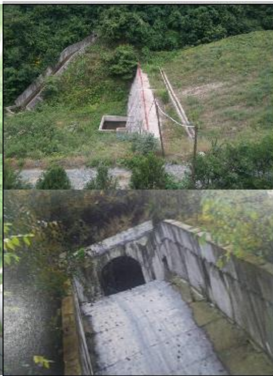
照片 3-23 尾矿库坝体及排洪涵洞出口占压
