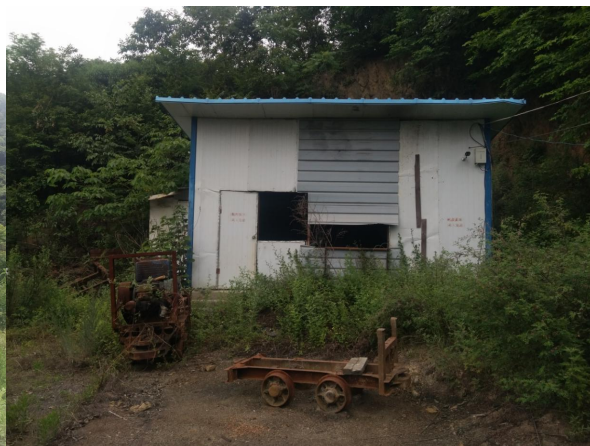
照片 3-25 PD6 平硐坑口临时建筑占压
