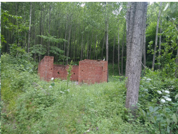
照片 1-9 PD3 平硐坑口临时建筑（破损）
