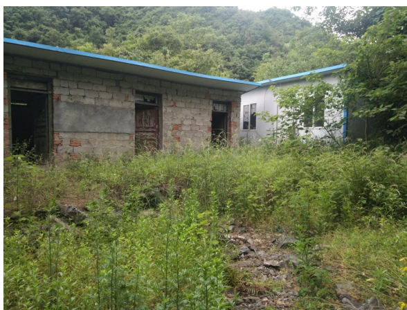
照片 1-3 金矿采区 PD4 平硐坑口临时建筑物
