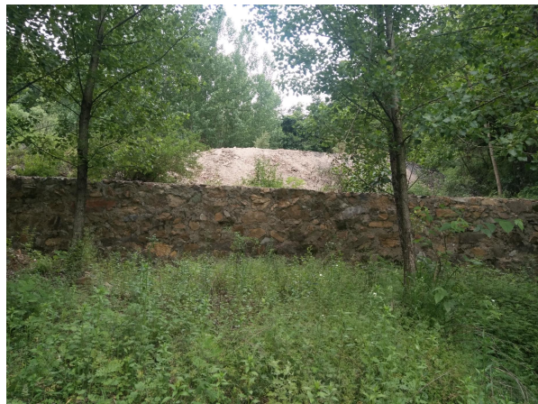
照片 3-18 ZD3 废石场对地形地貌影响
