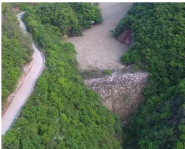
照片 2-18 废石场下部修建的挡墙
