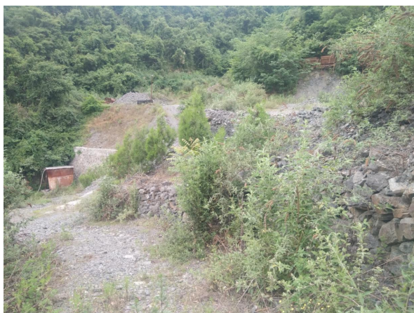
照片 3-3 金矿采区 ZD1 废渣堆边坡情况
