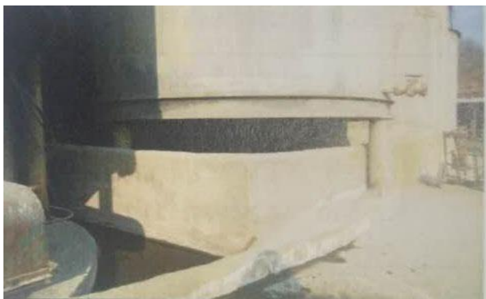
照片 1-14 事故池围堰
