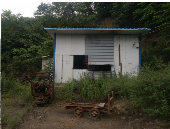
照片 1-7 PD6 平硐坑口临时建筑
