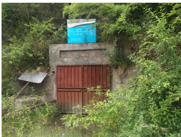
照片 1-1 金矿采区 PD1 平硐坑口
