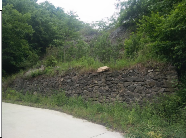
照片 3-17 ZD2 废石场对地形地貌影响
