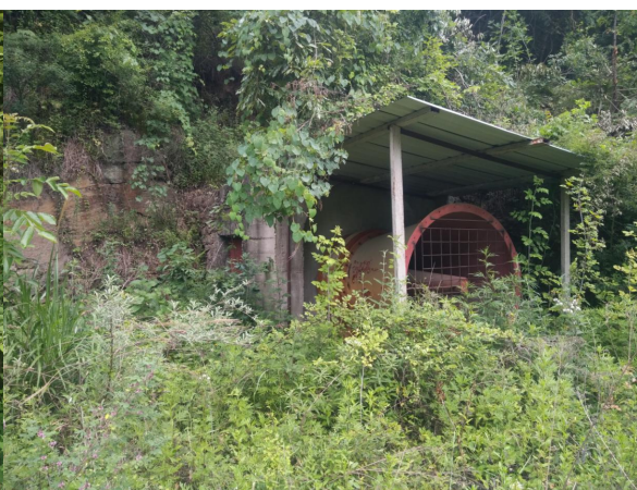
照片 1-2 金矿采区 PD2 平硐坑口
