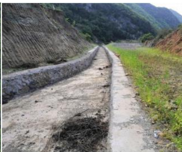
照片 2-19 废石场上方修建的排水渠
