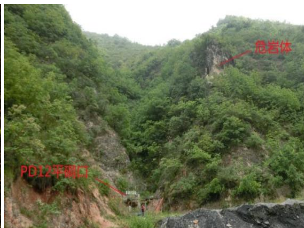
照 2-28 五色沟 PD12 坑口崩塌隐患 (B02)
