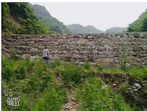
照片 2-31 PD4 渣堆下游拦渣坝 (镜向 105°)
