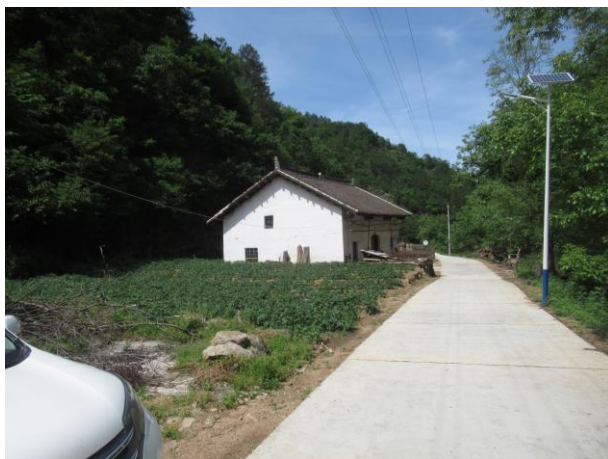
照片 2-17 矿区住宅用地及道路（镜向 350°）
