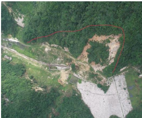
照 2-25 五色沟羊角崖滑坡(H01)
