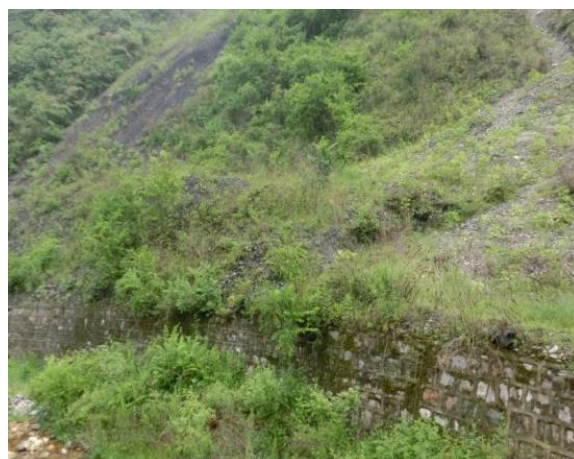
照片 2-32 ZD1 挡渣墙 (镜向 70°)
