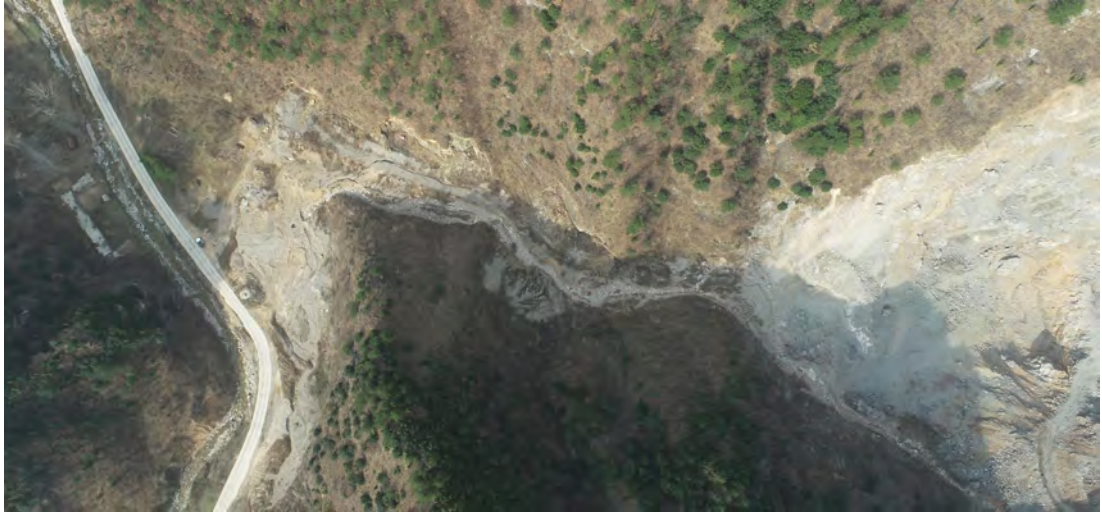
照片 3-10 矿山道路现状（镜向 295°）
