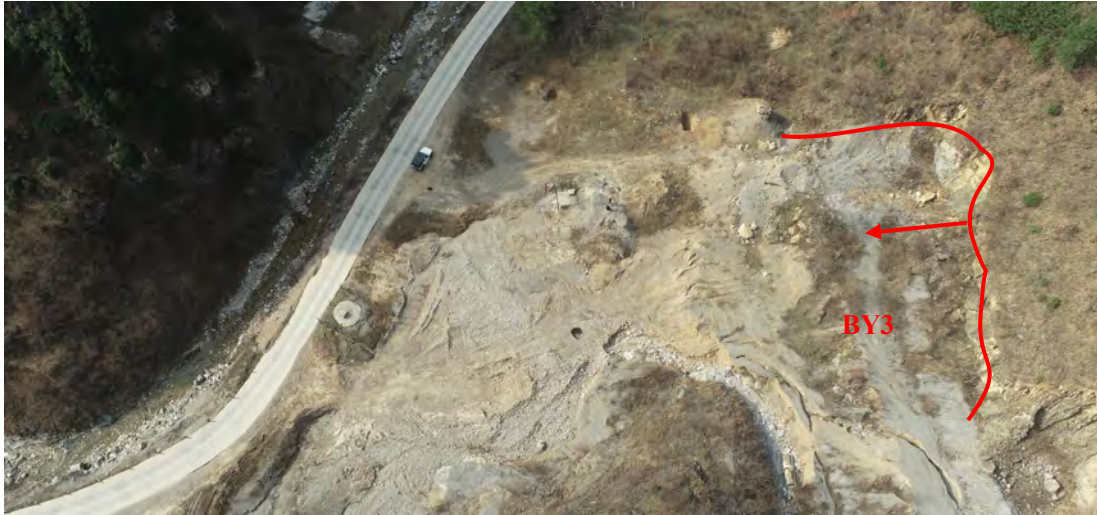
照片 3-7 BY3 隐患（镜向 320°）
