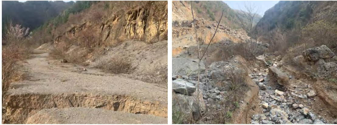
照片 3-12 矿山道路现状（镜向 295°）
