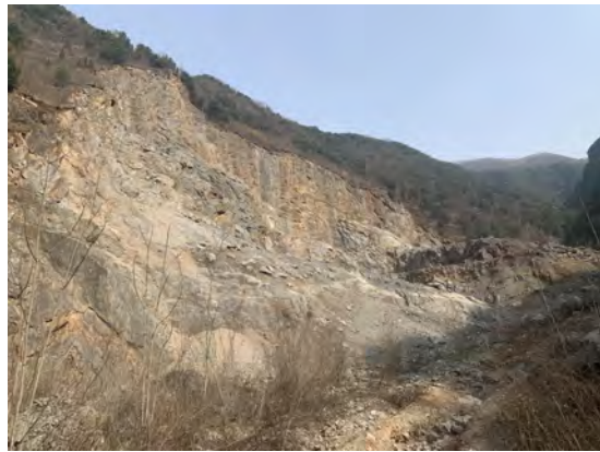
照片 3-3 BY1 隐患（镜向 27°）
