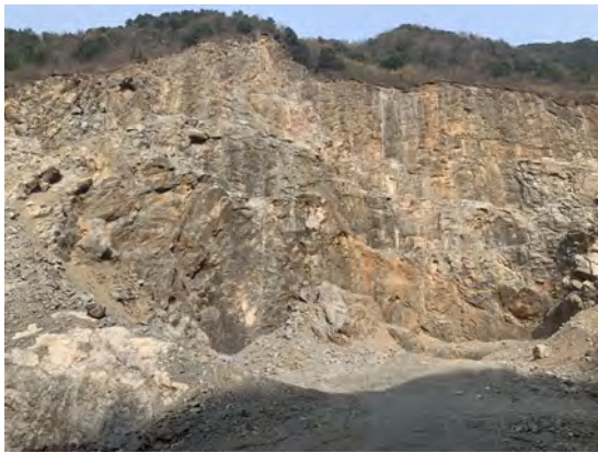
照片 3-2 BY1 隐患（镜向 320°）
