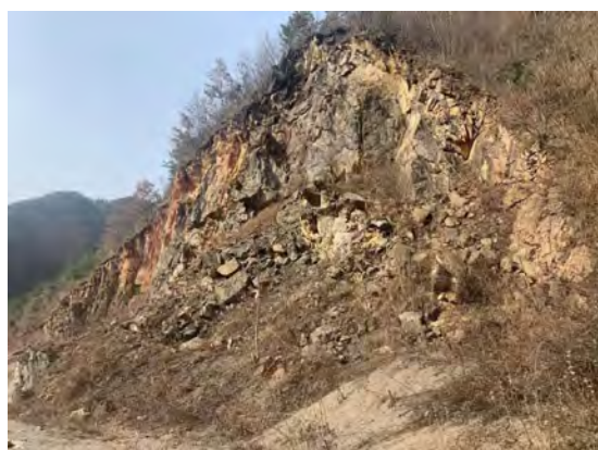
照片 3-6 BY2 隐患（镜向 258）
