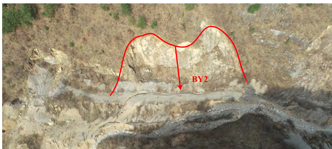
照片 3-5 BY2 隐患（镜向 320°）
