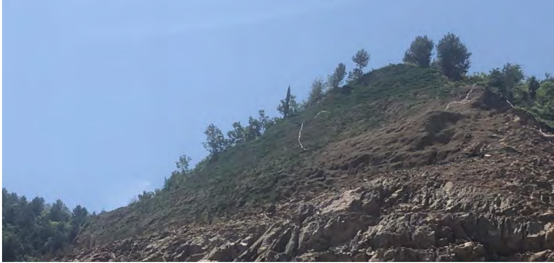
照片 2-10 边坡复绿工程
