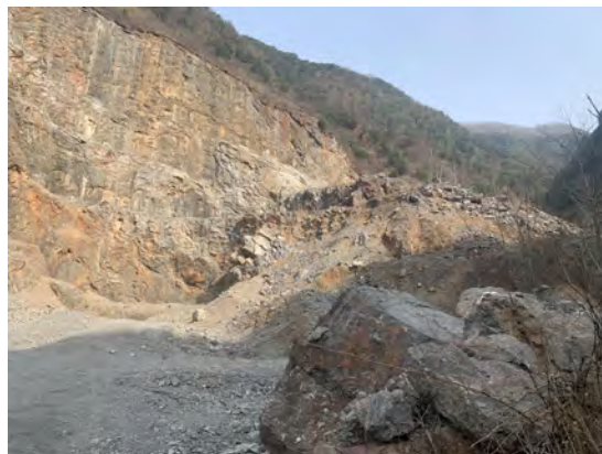
照片 3-4 BY1 隐患（镜向 20°）
