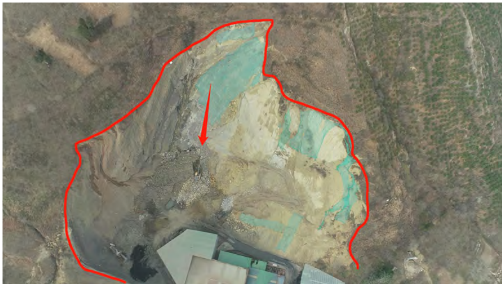
照片 3-1 H1 滑坡隐患
