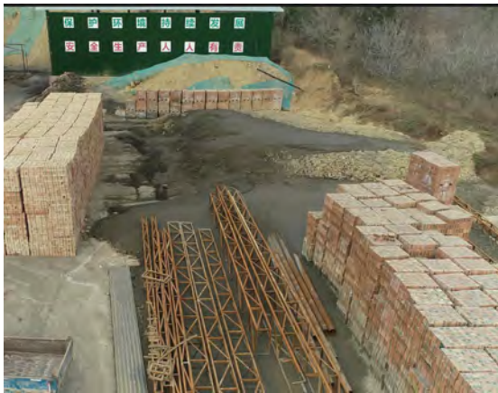
照片 1-11 临时堆料场
