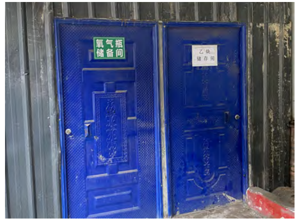
照片 1-8 氧气瓶、乙炔储藏间
