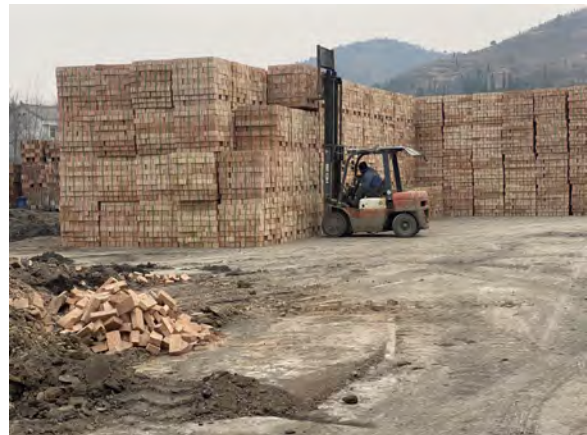
照片 1-12 临时堆料场
