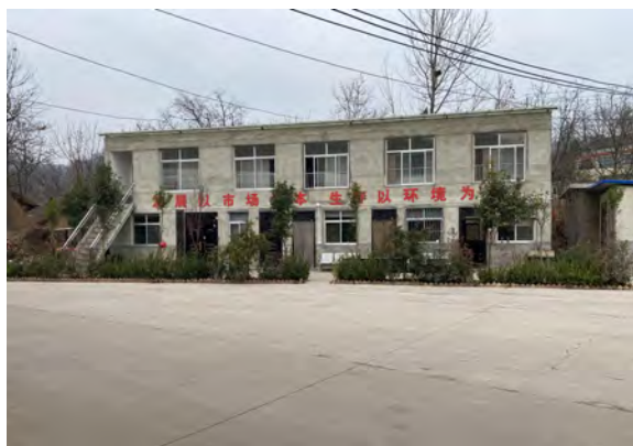
照片 1-1 办公生活区 楼房
