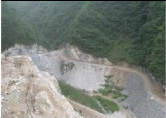
照 2-7 选厂边坡治理前
