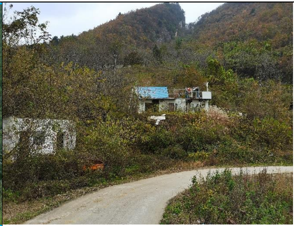
照 3-6 崩塌 2021 年（镜向西北）
