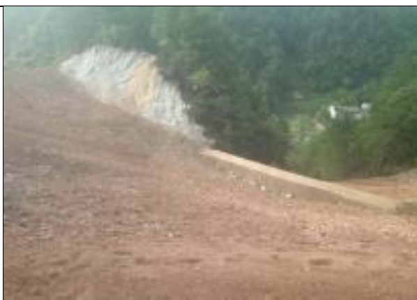
照 2-12 塌陷坑治理后
