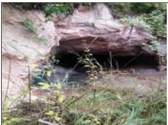
照 2-11 塌陷坑治理前
