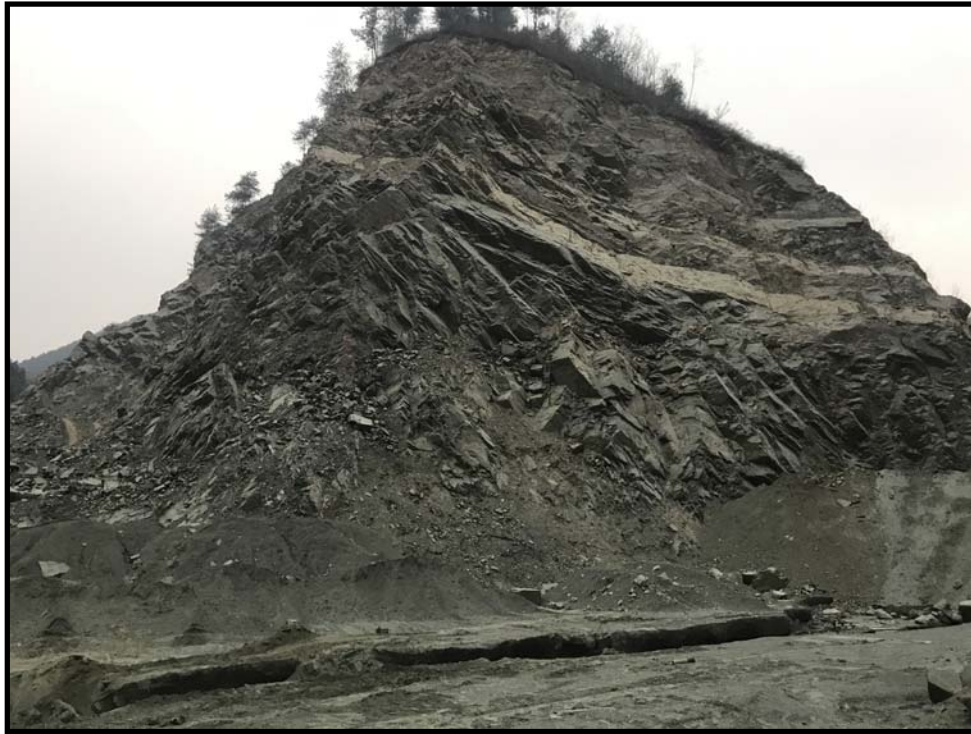
照片 3-1 B1 崩塌隐患点
