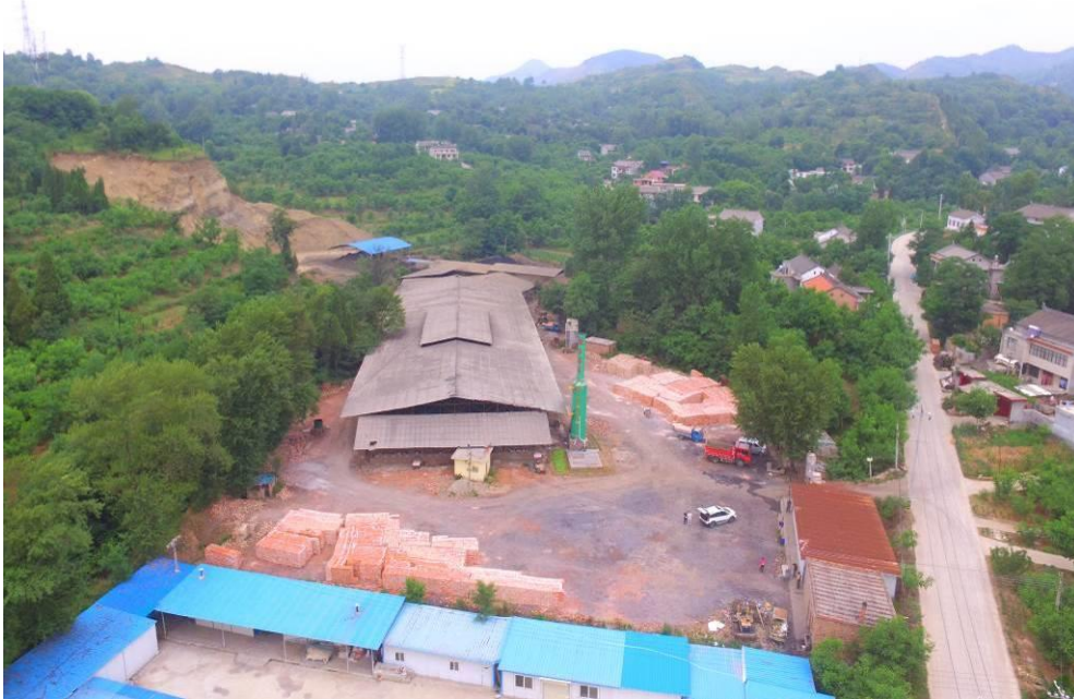
照片 3-2 工业场地建设破坏地形地貌
