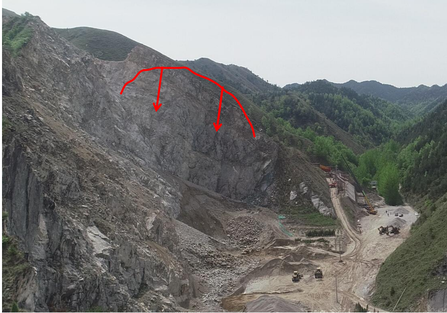
照片 3-1 B1 滑坡隐患点
