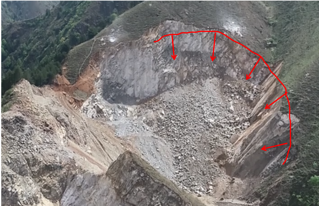
照片 3-2 B2 崩塌隐患点
