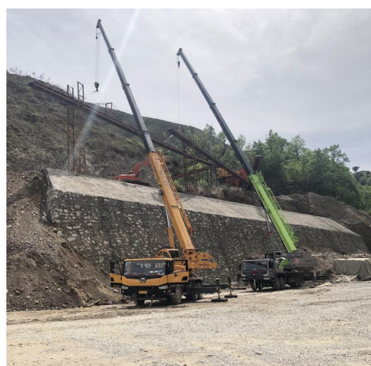
照片 2-5 修建挡墙
