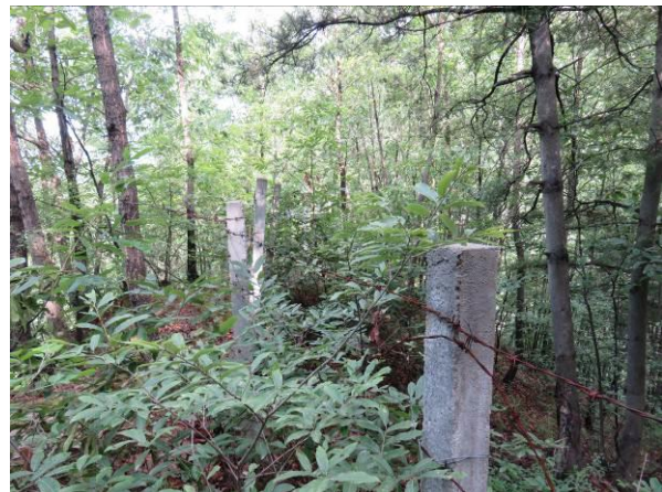
照 2-13 TX1 预防工程（刺死围栏）
