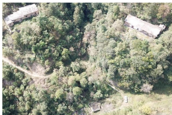
照 1-5 拟扩建矿山道路2现状(镜向 265°)
