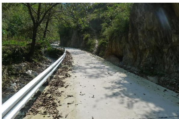
照 1-2 凉水沟内农村道路(镜向 185°)
