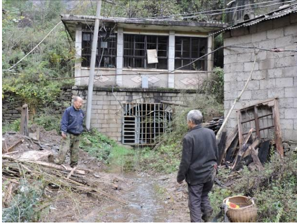
照片 2-10 硐口封堵工程
