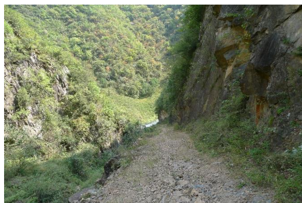
照 1-3 大冻沟内农村道路(镜向 155°)
