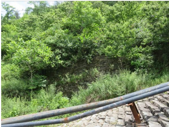
照 2-12 BT12 治理工程（挡土墙）
