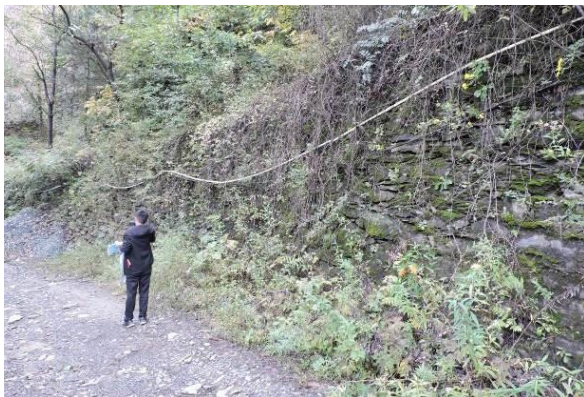
照片 2-8 崩塌边坡治理效果
