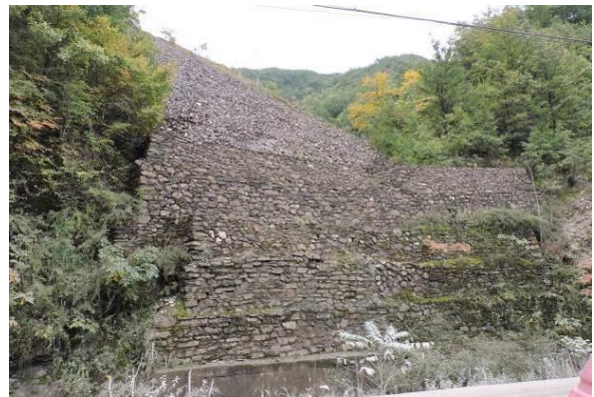
照片 2-9 渣堆 4 底部挡墙加高工程
