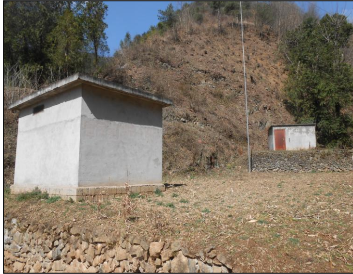
照片 3-3 炸药库、雷管库（镜向 310°）
