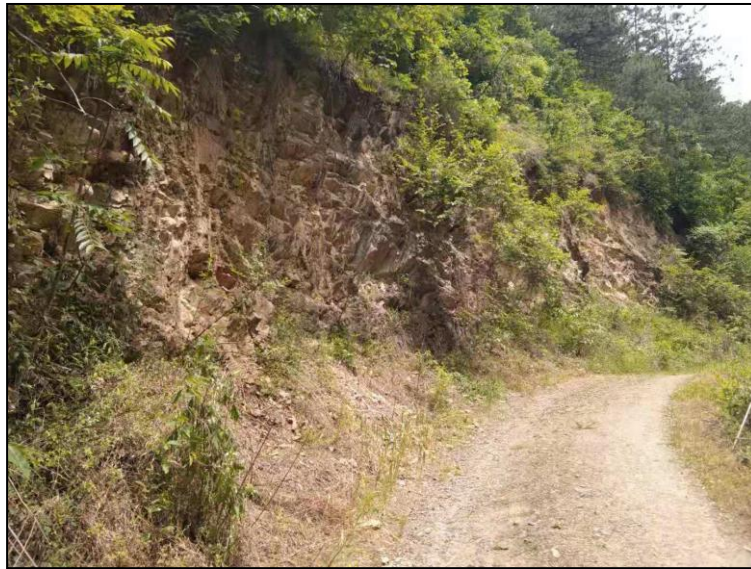
照片 3-3 矿山道路边坡情况
