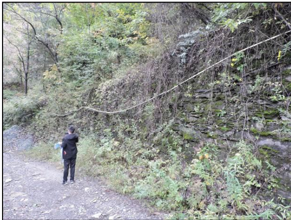
照片2-12 崩塌边坡治理效果
