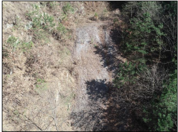
照片 3-6 Z2 废渣堆（镜向 120°）
