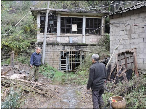
照片 2-14 硐口封堵工程
