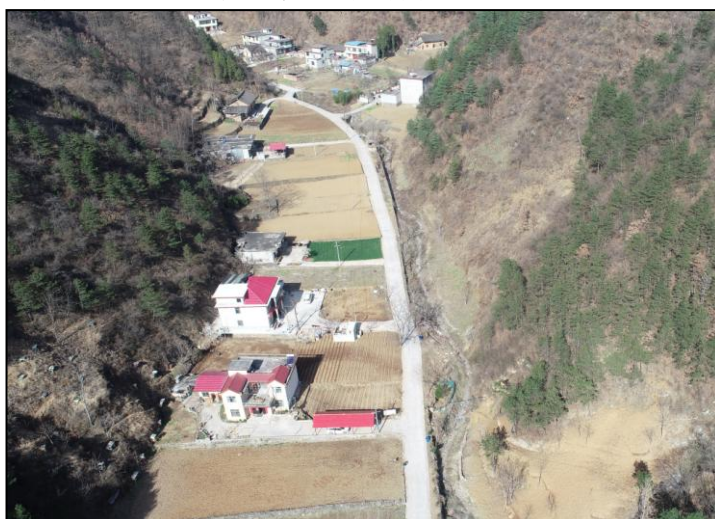
照片 2-11 筑房、修路（镜向 240°）
