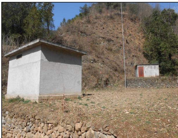
照片 1-11 炸药库、雷管库（镜向 310°）
