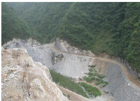
照片 2-17 选厂边坡治理前照片（镜向 28°）
