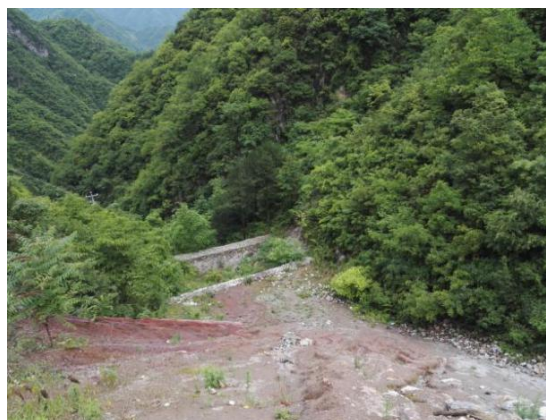
照片 2-20 已完工的 1170 硐口拦渣墙 （镜向 89°）
