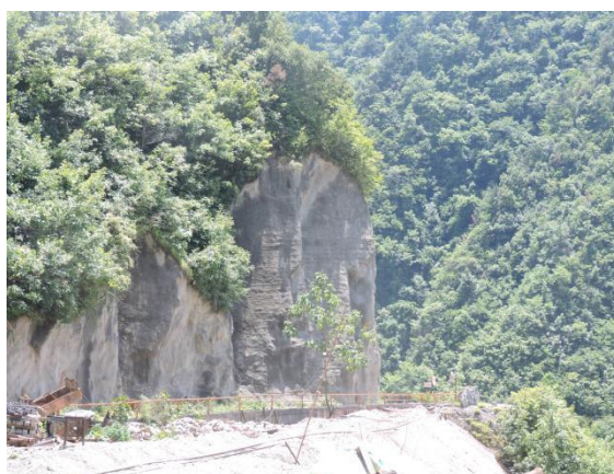
照片 2-16 高陡切坡喷锚支护（镜向 175°）
