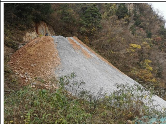
照片 2-12 柳树沟 ZD2（镜向 55°）
