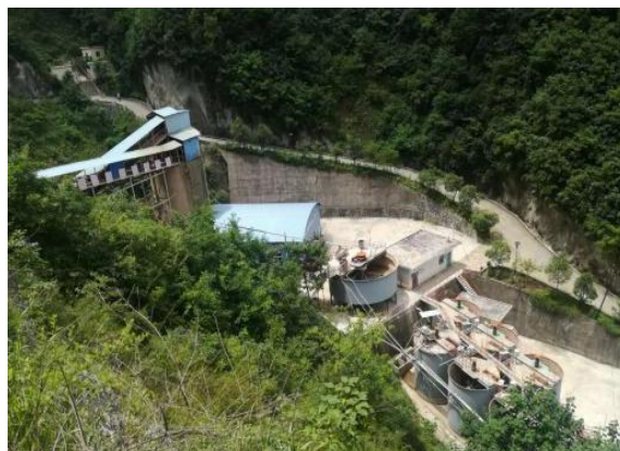
照片 2-18 选厂边坡治理后照片（镜向 36°）
