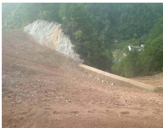
照片 2-15 塌陷坑治理后照片（镜向 36°）
