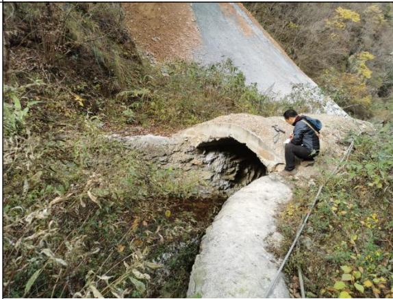
照片 2-15 ZD2-ZD3 涵洞排水设施（镜向 80°）
