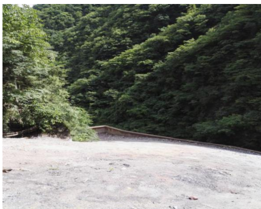
照片 2-19 已完工的 1050 坑口拦渣墙工程 （镜向 45°）
