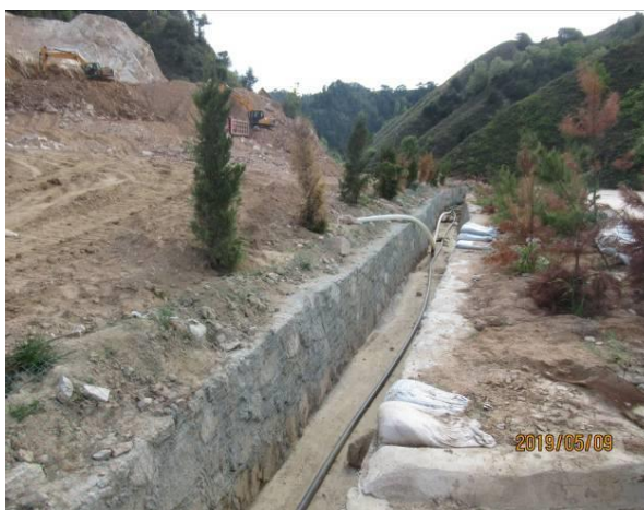
2-15 渣堆修建排水渠
