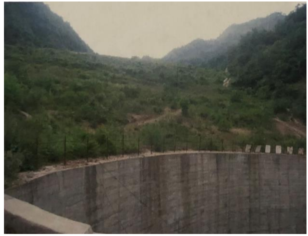
照片 2-11 西芦沟尾矿库整治
