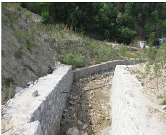
照片 2-14 修建排水渠
