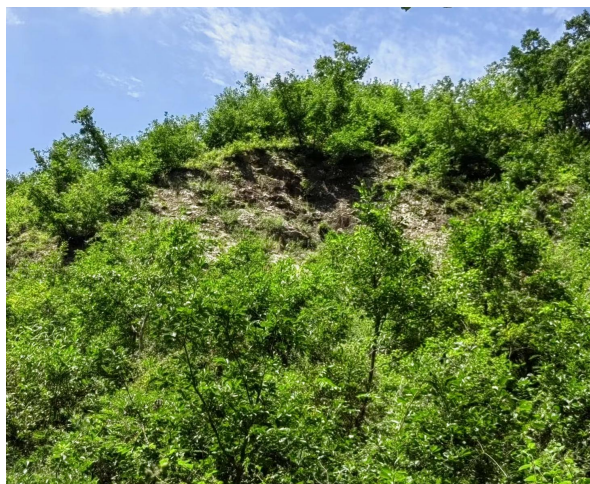
照片 2-6 崩塌危岩体治理后
