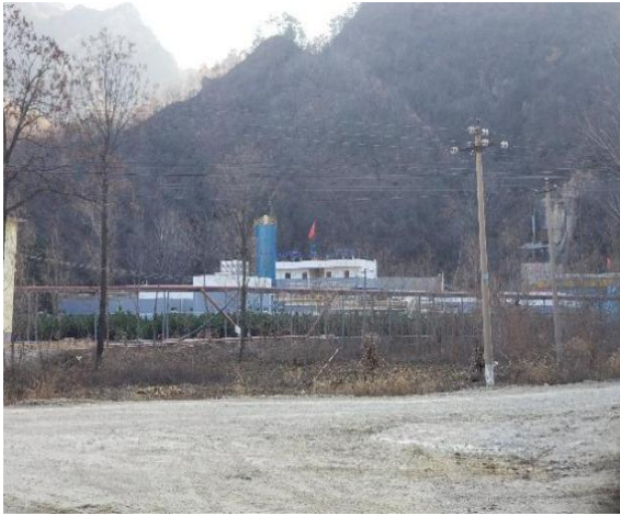
照片 2-11 污水处理厂
