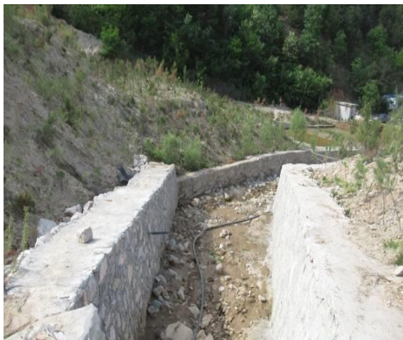
照片 2-15 修建排水渠
