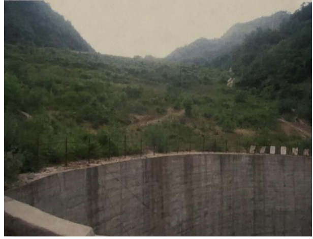
照片 2-12 西芦沟尾矿库整治
