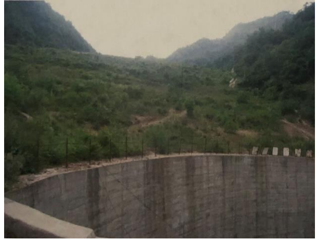
照片 2-11 西芦沟尾矿库整治
