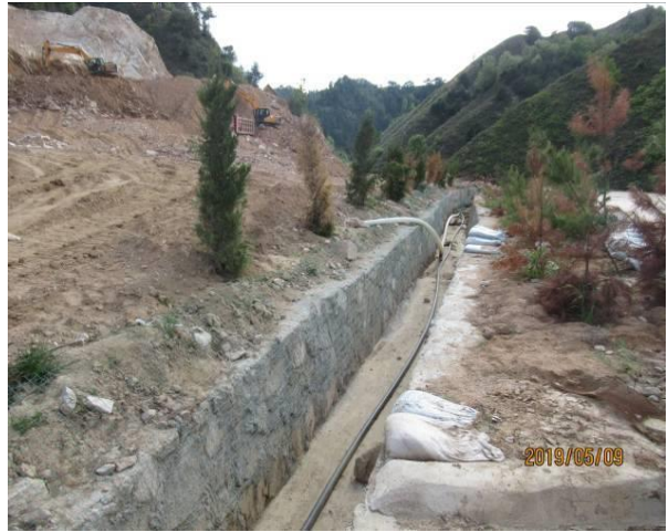
2-15 渣堆修建排水渠
