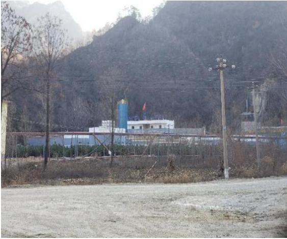
照片 2-10 污水处理厂
