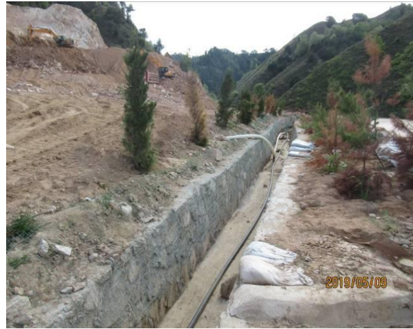
照片 2-14 渣堆修建排水渠
