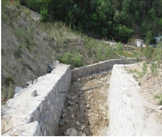
照片 2-13 修建排水渠
