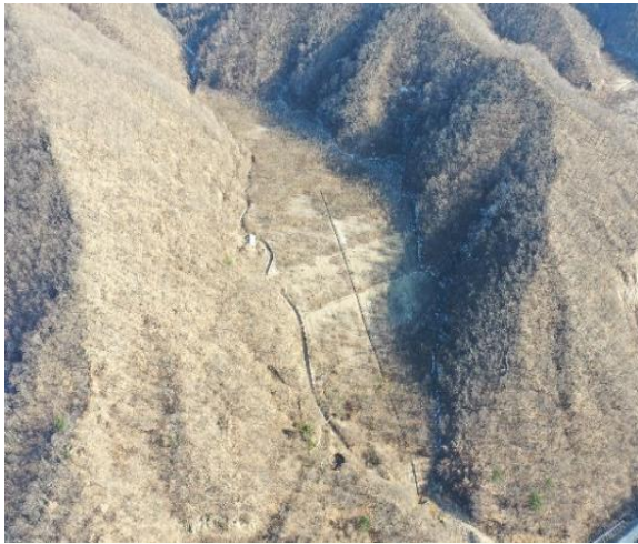
照片 2-11 小刺沟尾矿库
