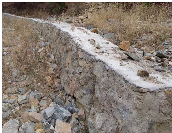
照片 2-16 渣堆修建挡墙
