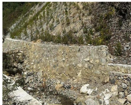
照片 2-17 渣堆修建排水渠
