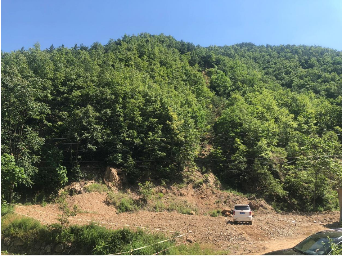
照片 2-11 废渣堆复垦工程（覆土）
