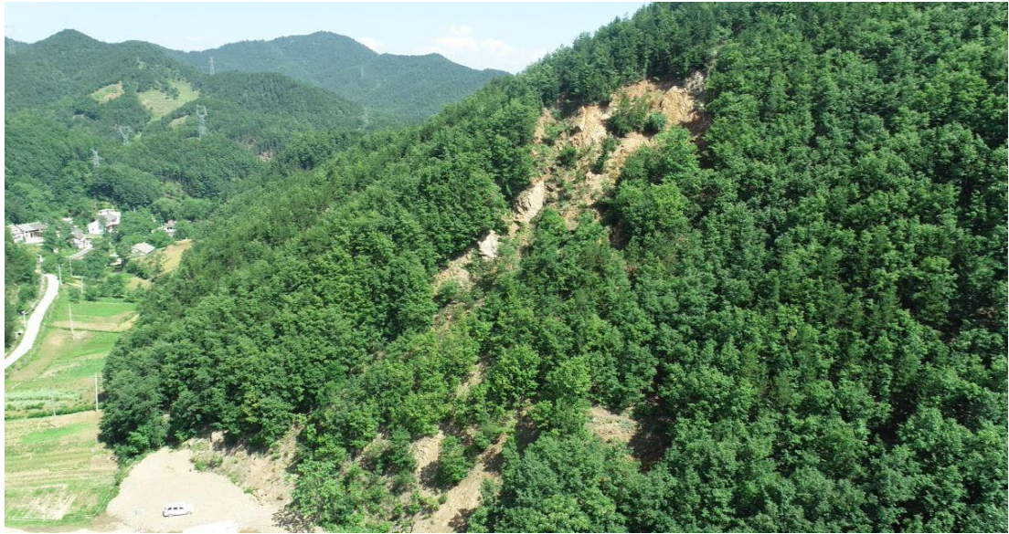
照片 3-1 崩塌隐患 (BY1)
