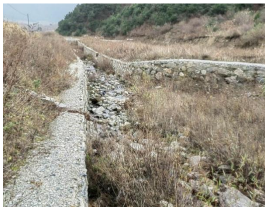
照片 2-15 废石场修建排水渠
