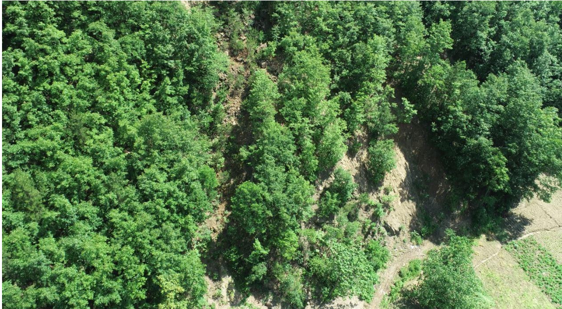
照片 2-10 B1 崩塌隐患点监测工程（2023 年 7 月）
