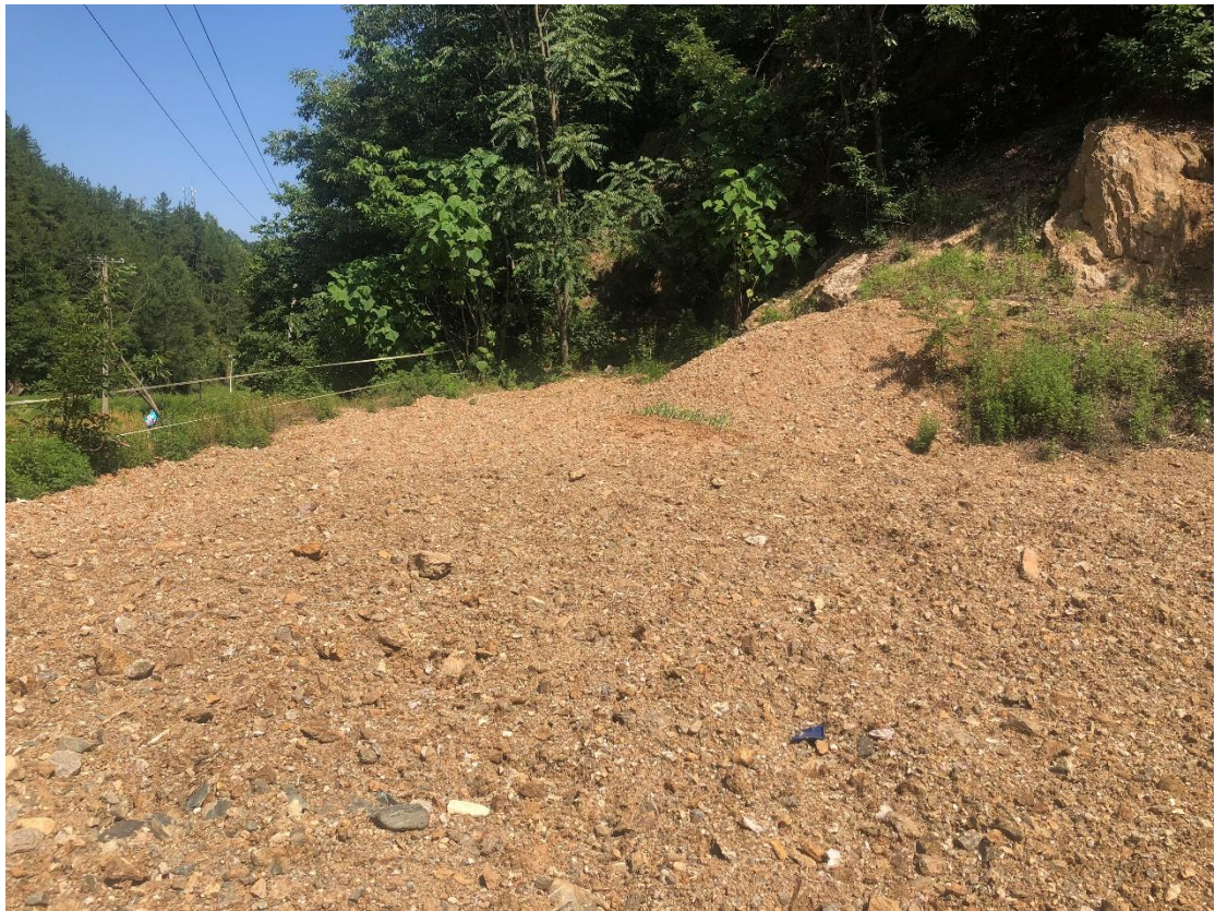
照片 2-12 废渣堆复垦工程（覆土）
