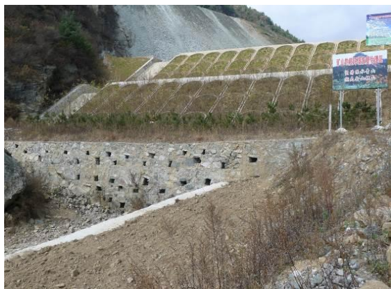
照片 2-14 废石场修建拦渣坝
