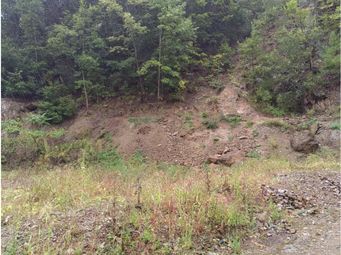
照片 2-13 废渣堆复垦工程（撒播草籽）
