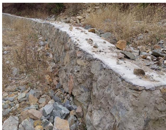
照片 2-12 渣堆修建挡墙
