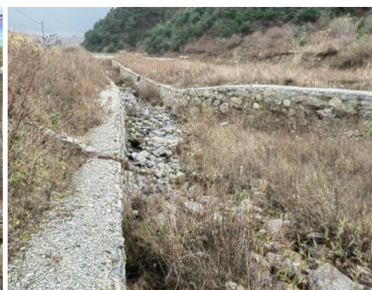
照片 2-11 废石场修建排水渠
