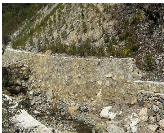
照片 2-13 渣堆修建排水渠
