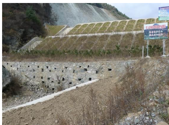
照片 2-10 废石场修建拦渣坝
