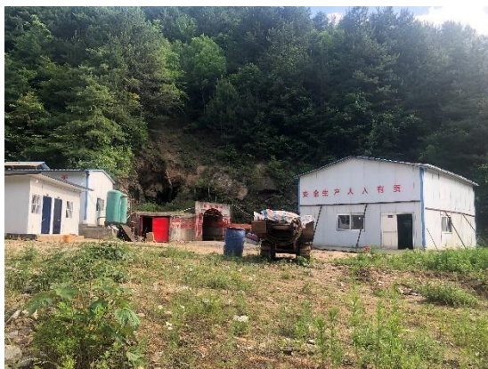
照片 1-7 头条沟工业场地
