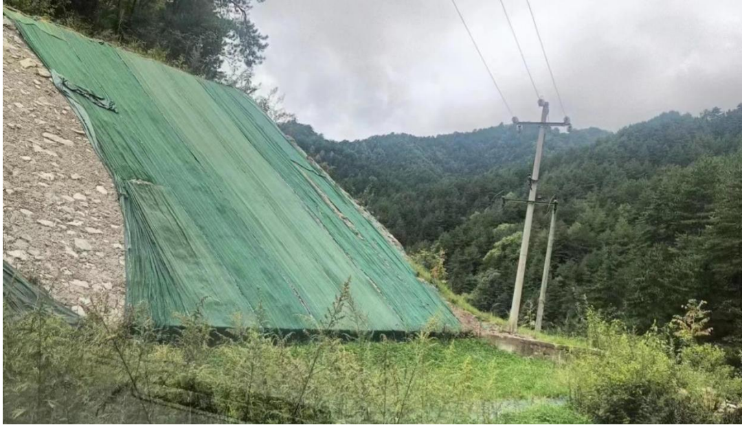
照片 2-13 Z1 废渣堆修建浆砌石挡墙
