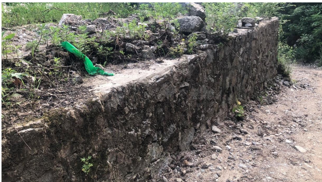
照片 2-12 Z1 废渣堆修建浆砌石挡墙
