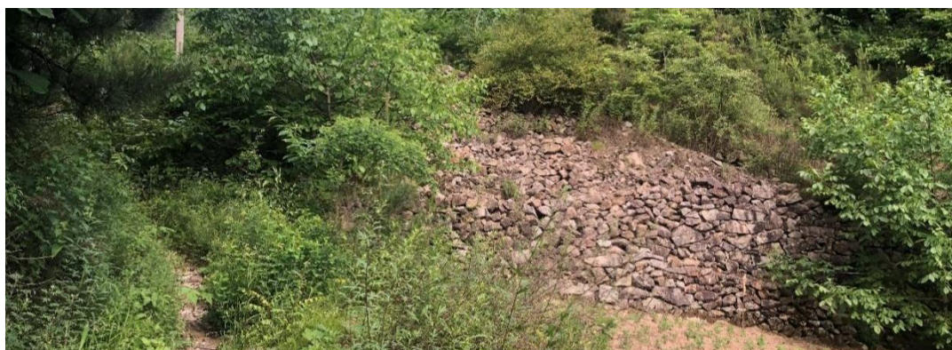
照片 2-15 Z3 废渣堆修建干砌石挡墙
