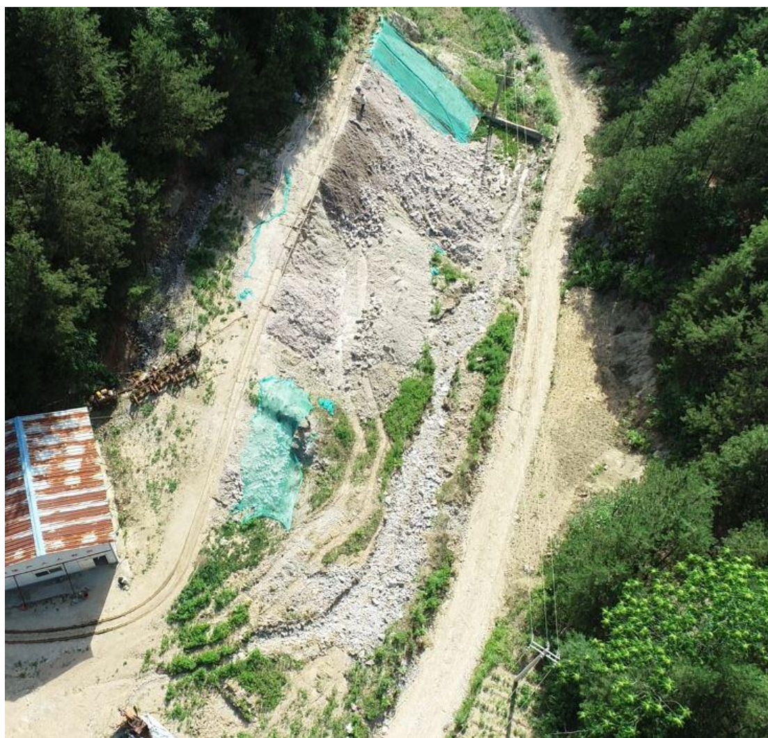
照片 3-1 N1 泥石流隐患点
