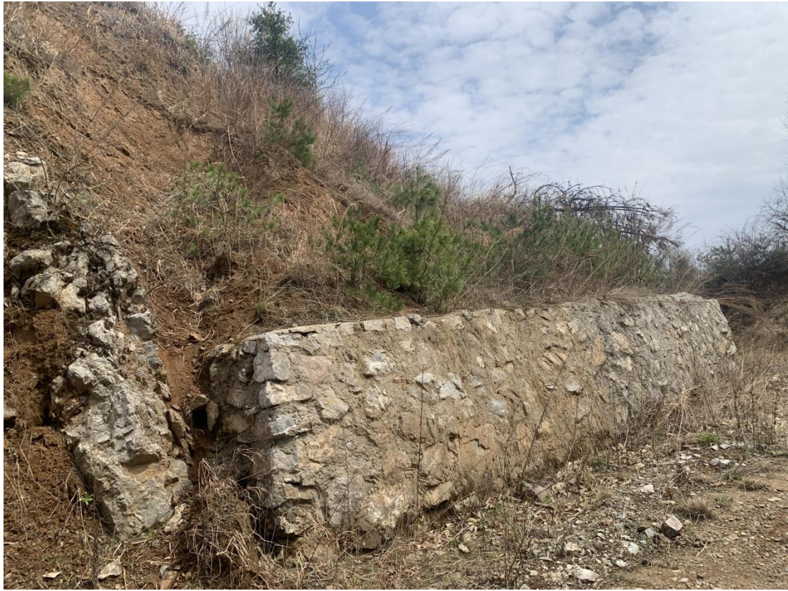
照片 2-12 H1 滑坡治理浆砌石挡墙工程
