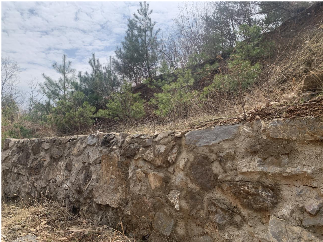
照片 2-13 H2 滑坡治理浆砌石挡墙工程
