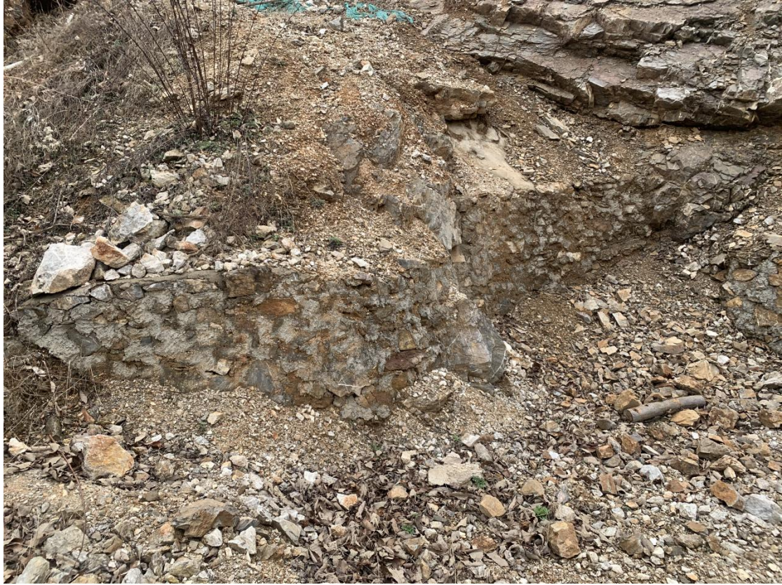
照片 2-10 H4 滑坡治理浆砌石挡墙
