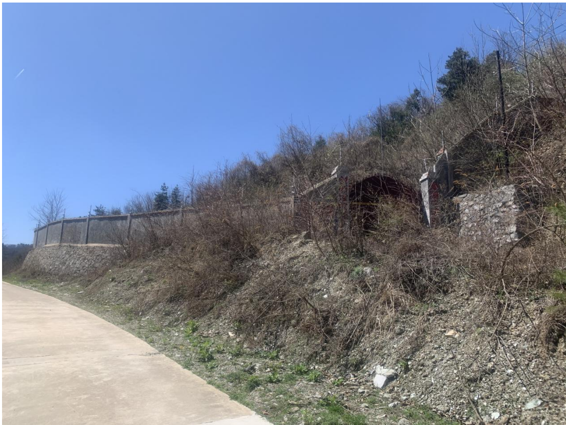
照片 1-6 K1 矿体炸药库
