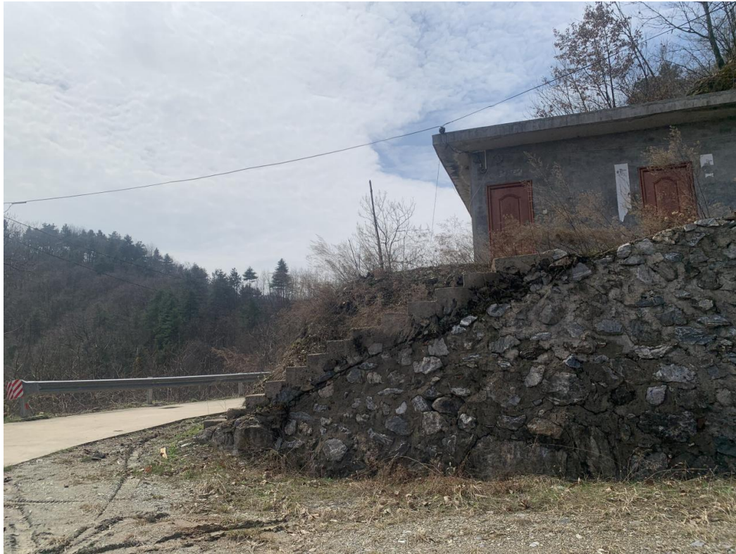
照片 3-7 K1 矿体值班室
