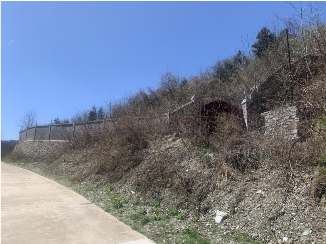
照片 3-6 K1 矿体炸药库
