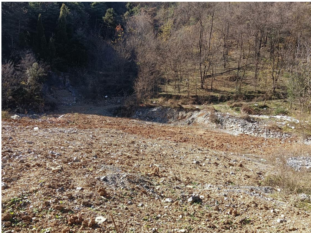
照片 2-20 卸矿平台平整覆土工程
