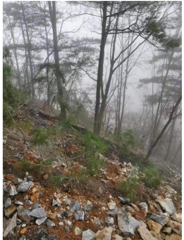
照片 2-19 废渣场绿化工程
