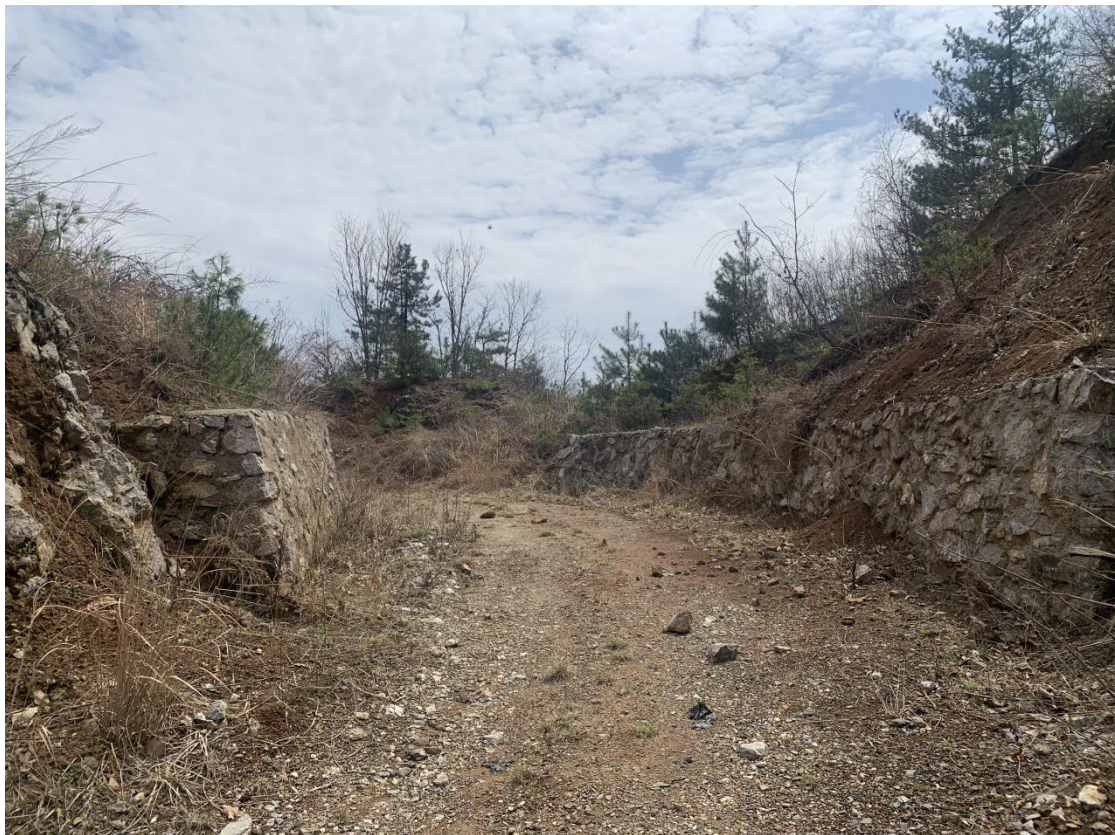
照片 2-11 H1、H2 滑坡治理浆砌石挡墙
