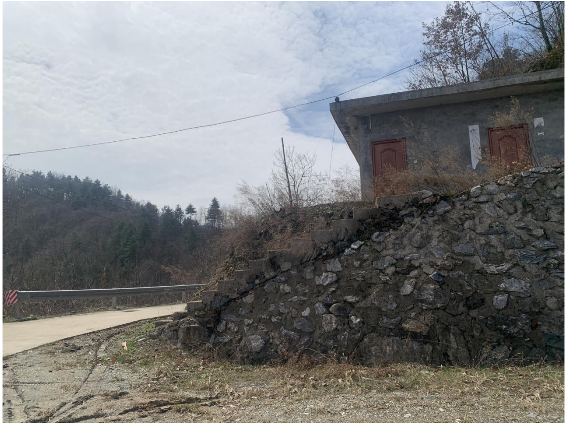
照片 1-7 K1 矿体值班室
