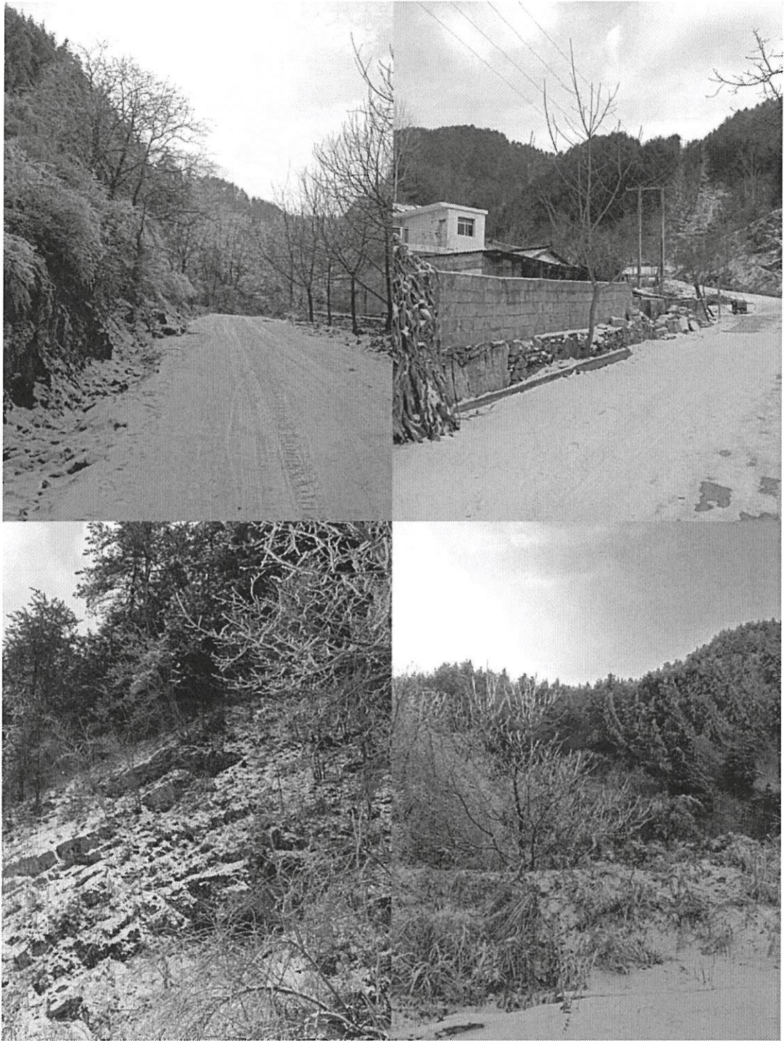
评估人员现场勘查图片
