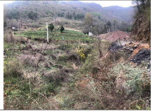
进场土石道路
